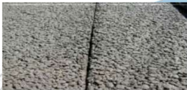
Imagen 34. Juntas o Cortes del Concreto
