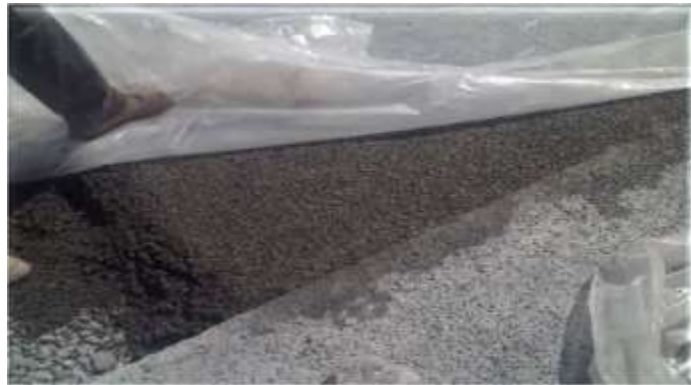
Imagen 35. Curado del Concreto
