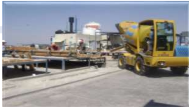
Imagen 31. Fabricación del Concreto
