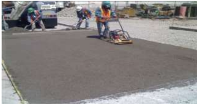
Imagen 33. Compactación del Concreto
