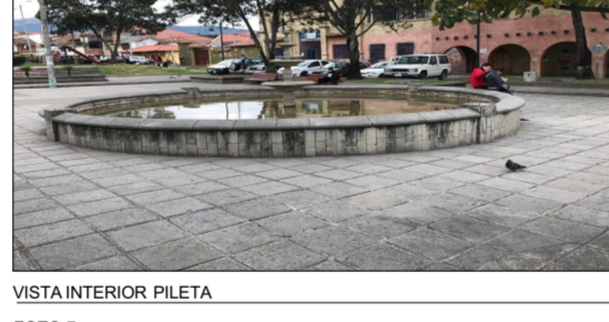
VISTA INTERIOR PILETA
