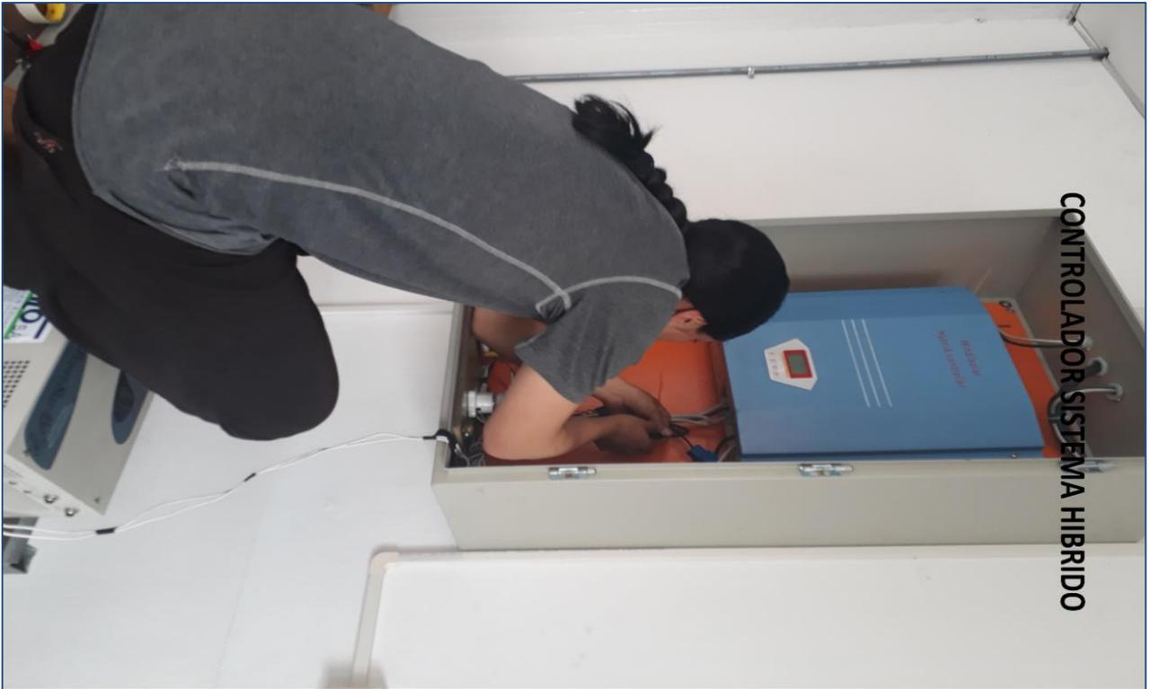
Ilustración 6. Instalación de los Sensores de Medición.
