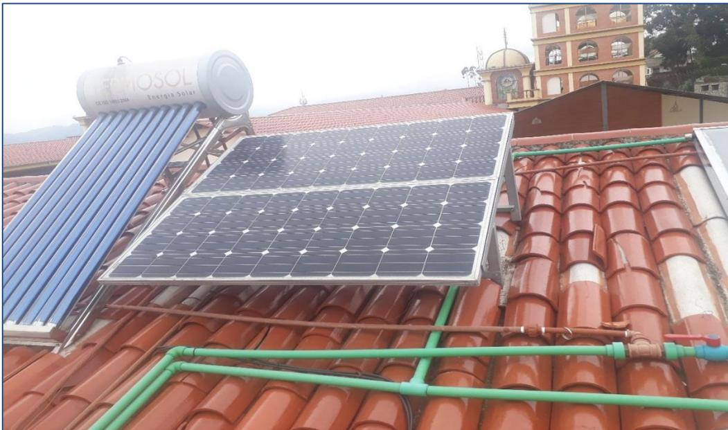
*Ilustración 2. Panel Solar Fotovoltaico de 140w
