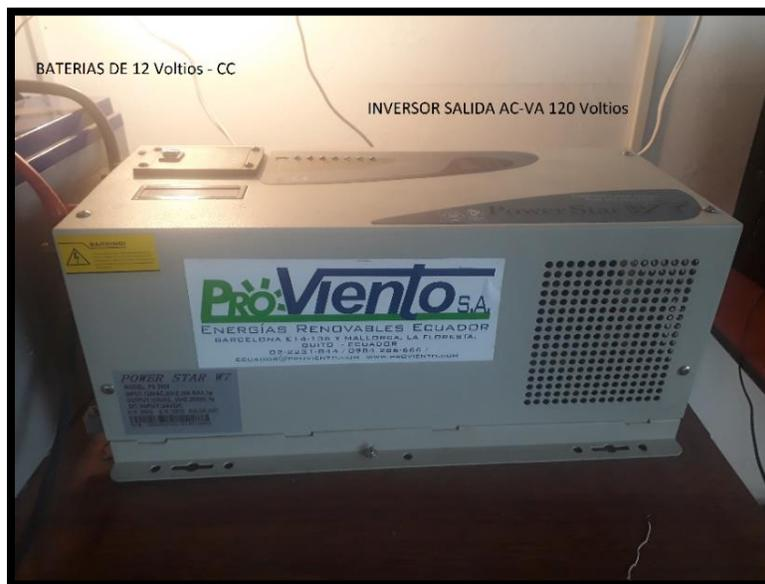
Figura 16. Inversor de 120 Voltios (AC-VA).
