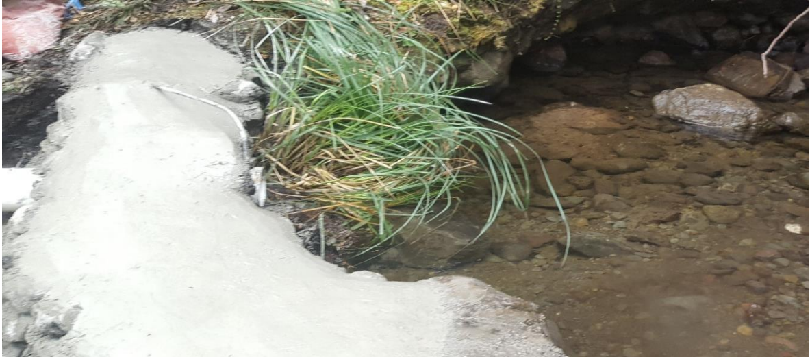
Fig. 42 Obra de Bocatoma (Autores, 2018)
