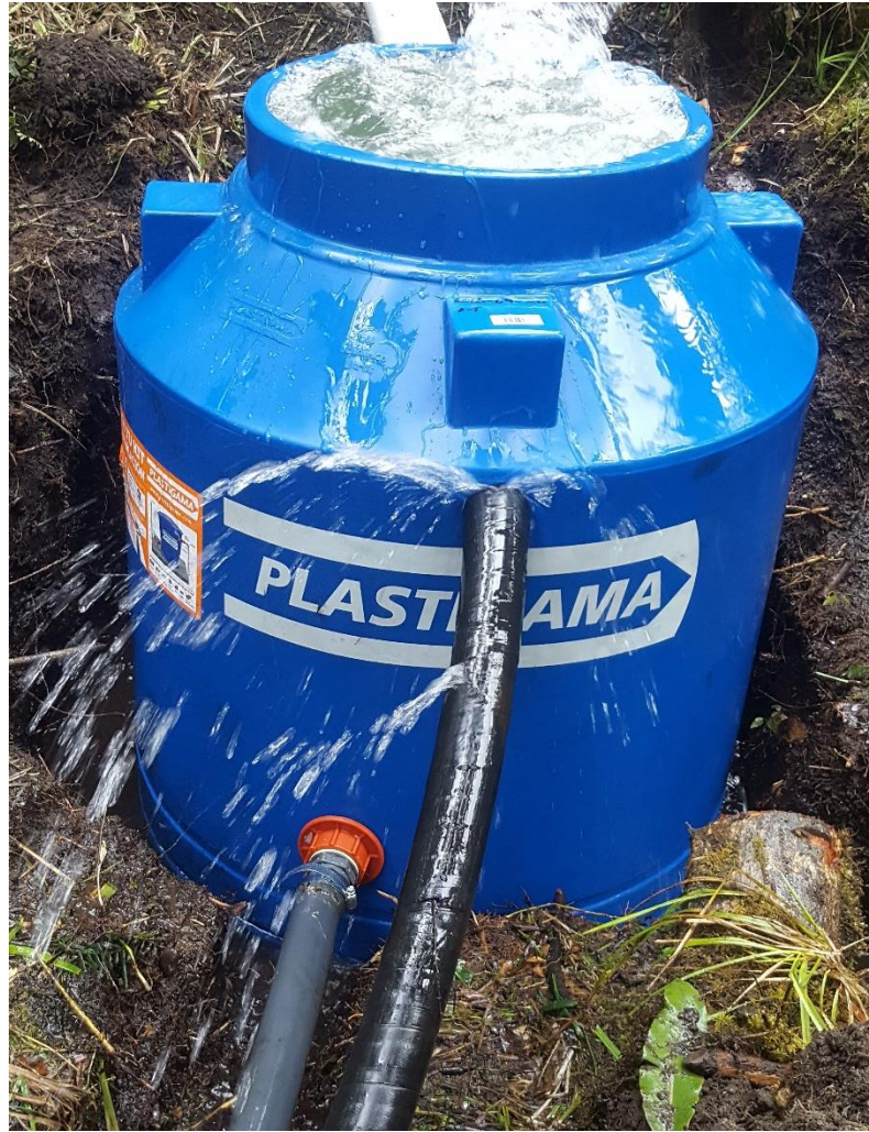
Fig. 47 conexión de la tubería de presión. (Autores, 2018)
