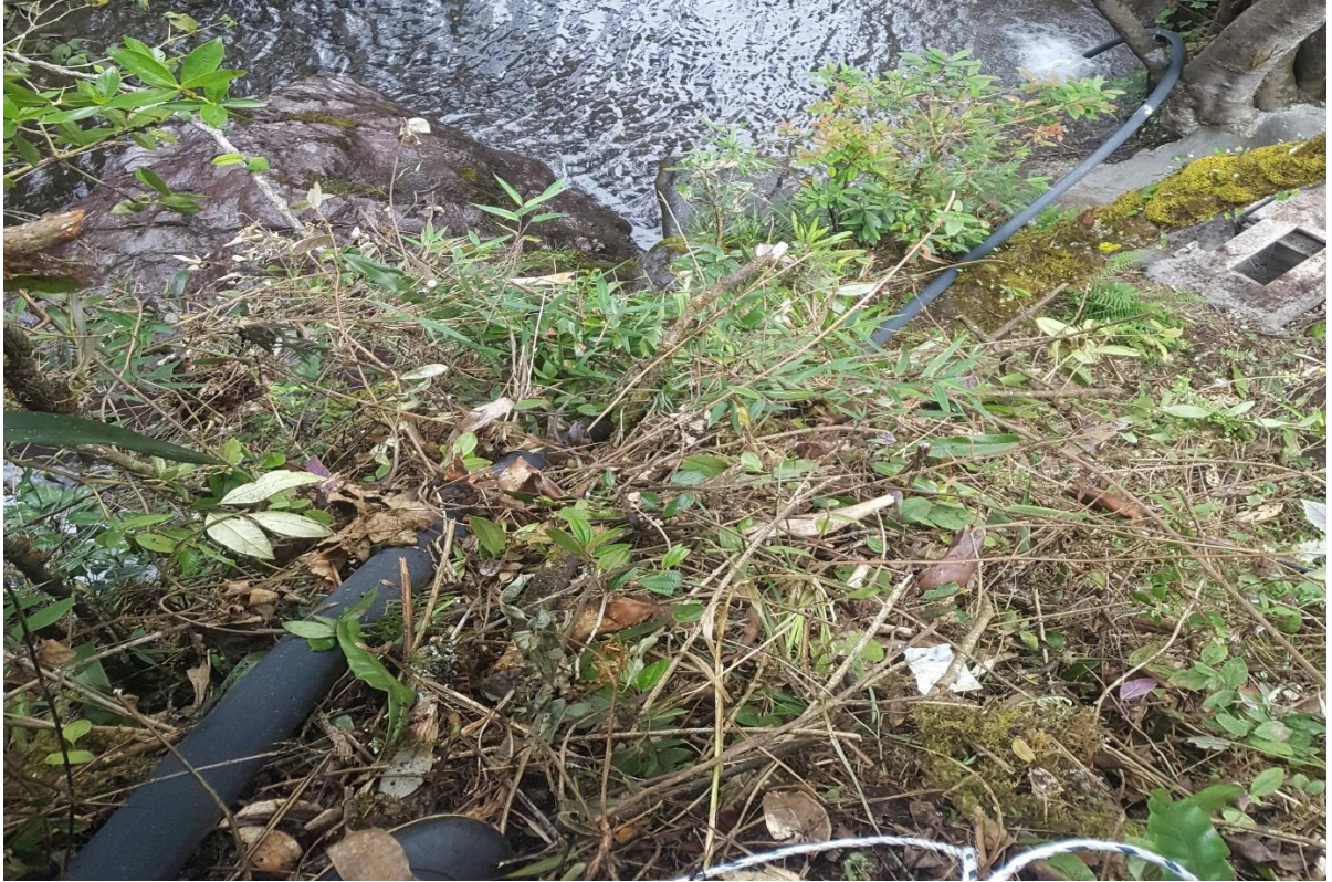
Fig. 39 Medición de la longitud de la tubería. (Autores, 2018)
