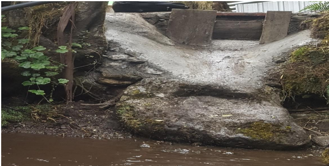
Fig. 51 Canal de descarga. (Autores, 2018)
