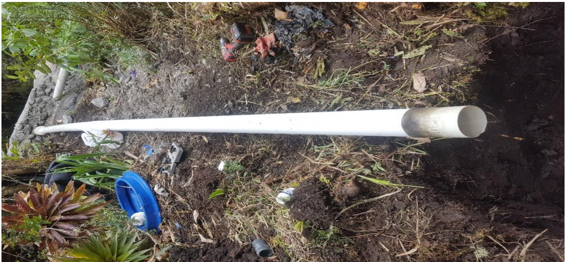
Fig. 44 Canal de derivación cerrado. (Autores, 2018)
