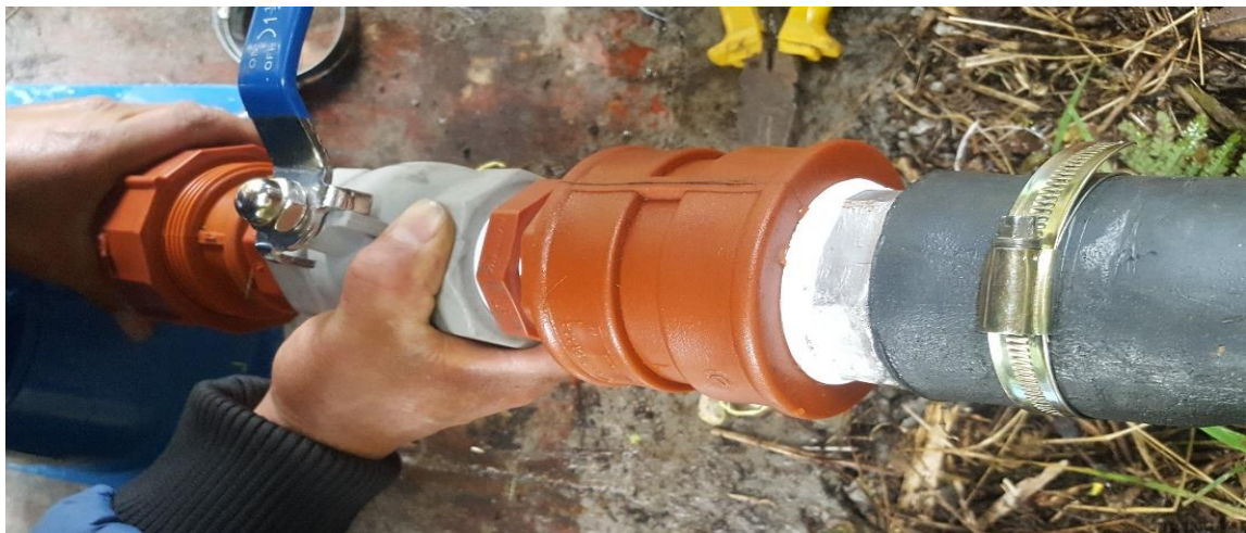
Fig. 57 Instalación final de la turbina a la tubería de presión. (Autores, 2018)
