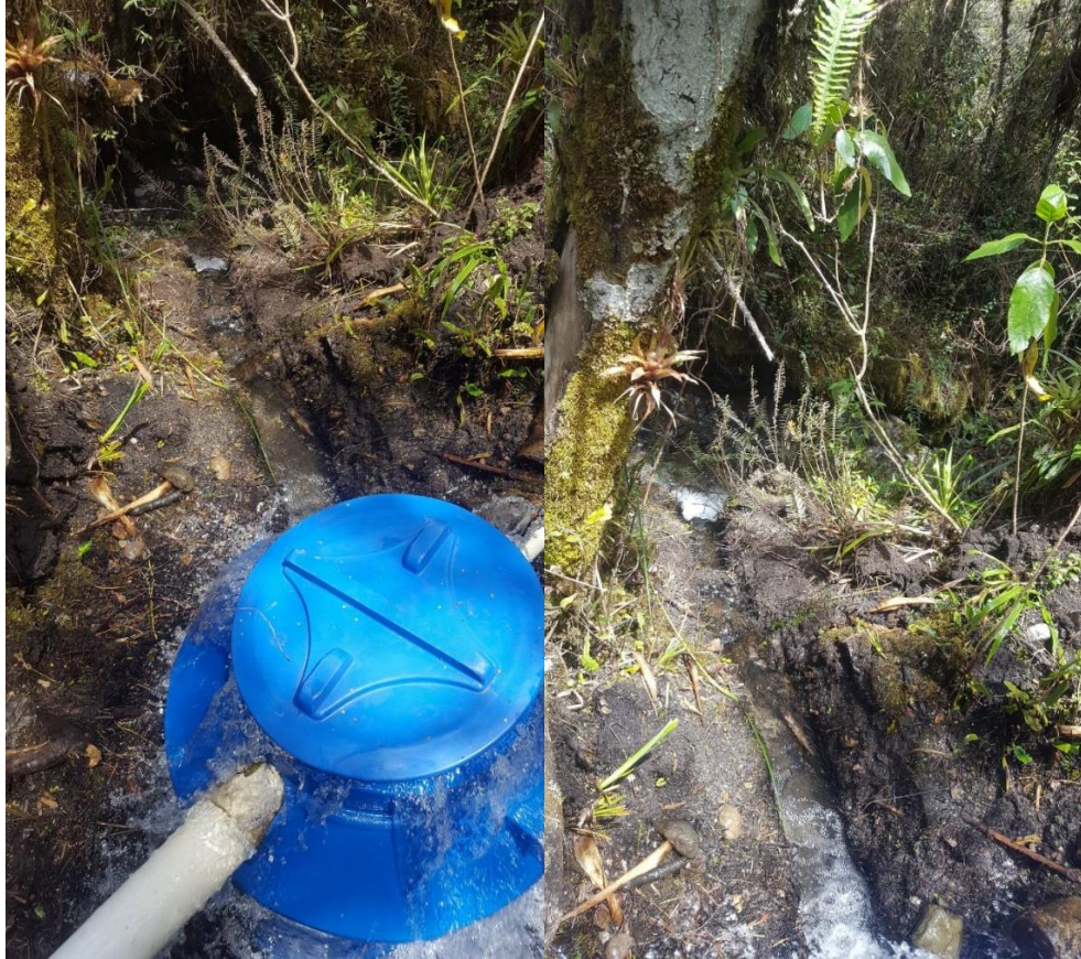
Fig. 46 Canal de exceso de agua. (Autores, 2018)
