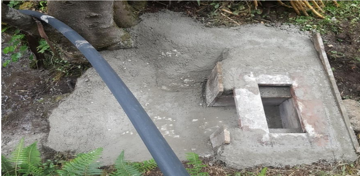
Fig. 50 Base de la turbina concluida. (Autores, 2018)
