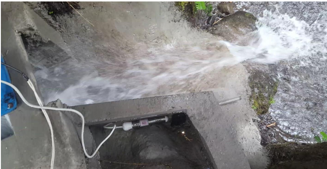
Fig. 53 Tanque de agua para el disipador. (Autores, 2018)
