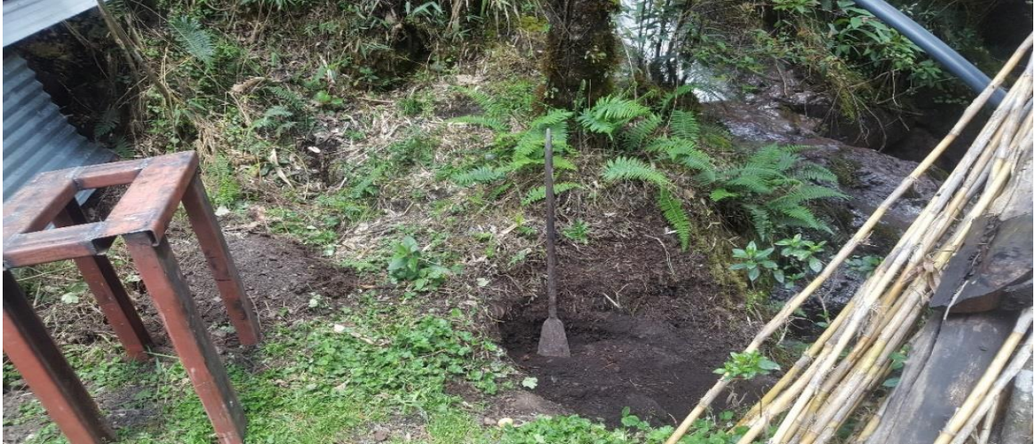
Fig. 49 Agujero para la ubicación del banco de la turbina. (Autores, 2018)
