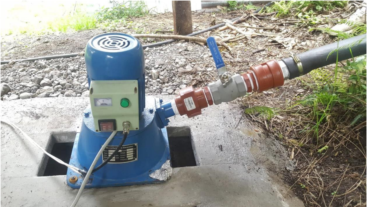
Fig. 58 Instalación final de la turbina (Autores, 2018)
