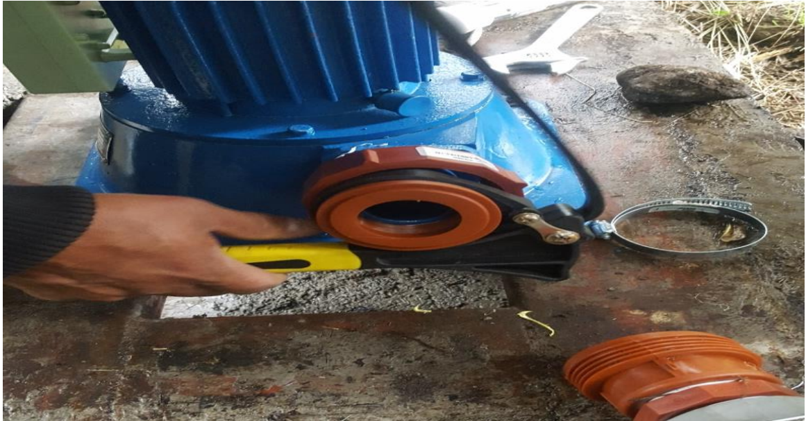
Fig. 56 Ajuste de los elementos con la llave francesa. (Autores, 2018)
