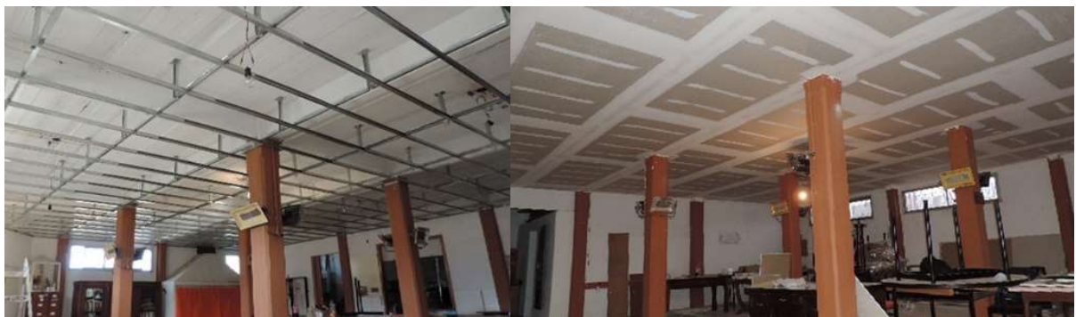
FIGURA 3.5: Armado de estructura de cielo raso fija.
