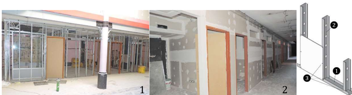
FIGURA 3.6: Panel prefabricado de yeso – cabuya
