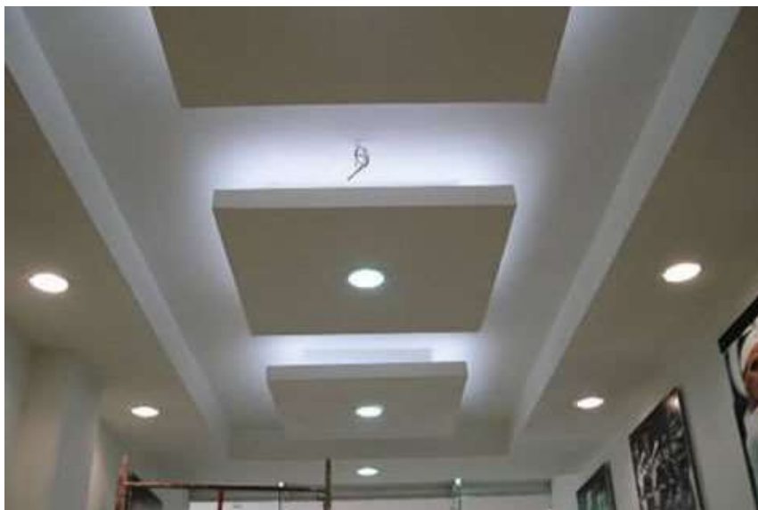
FIGURA 1.6: Techo falso a base de yeso.
