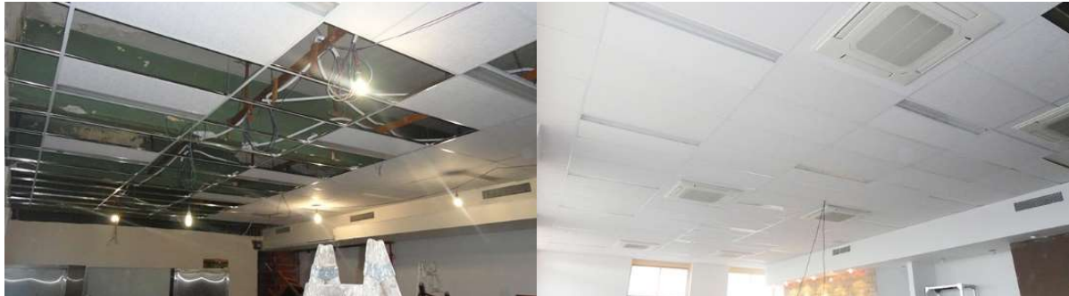
FIGURA 3.3: Armado de estructura de cielo raso desmontable.
