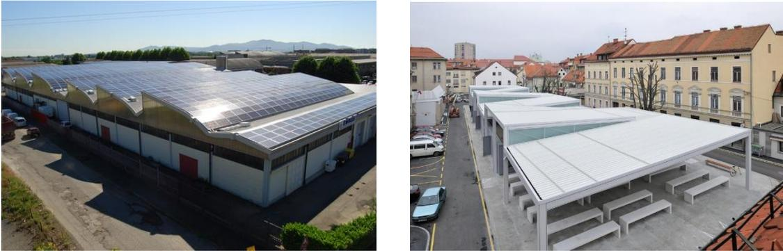
Figura 50. Ejemplos de cubierta diente de sierra.
