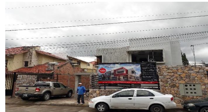
Imagen 15 V.3 Usos especiales; edificaciones en proceso de construcción Elaboración: María Paz González Durán
