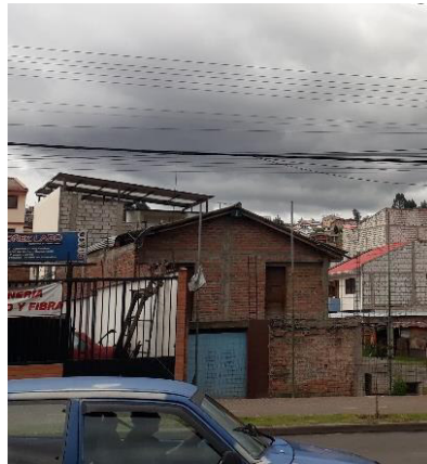
Imagen 41 Edificación 3 estado actual, 2018 Elaboración: María Paz González Durán
