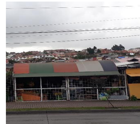
Imagen 74 Edificación 9 estado actual, 2018 Elaboración: María Paz González Durán
