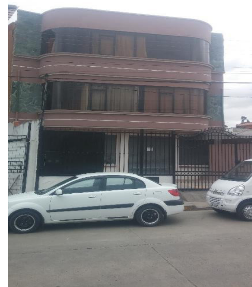
Imagen 57 Edificación 28 estado actual, 2018 Elaboración: María Paz González Durán
