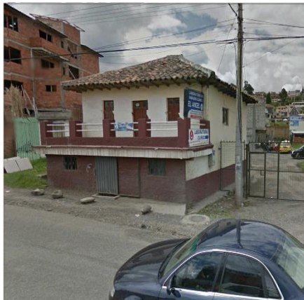
Imagen 40 Edificación 3 antes de la intervención en la Av. Ordóñez Lazo, 2015 Fuente: Fotografía Google Earth, 2015
