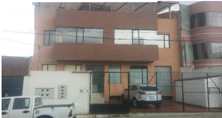
Imagen 59 Edificación 29 estado actual, 2018 Elaboración: María Paz González Durán
