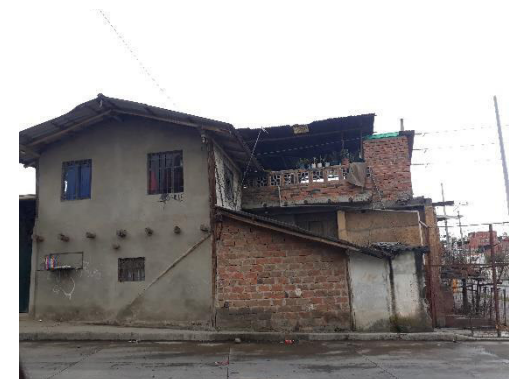
Imagen 78 Edificación 11 estado actual, 2018 Elaboración: María Paz González Durán
