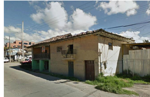
Imagen 66 Edificación 1 antes de la intervención en la Av. Ordóñez Lazo, 2015 Fuente: Fotografía Google Earth, 2015
