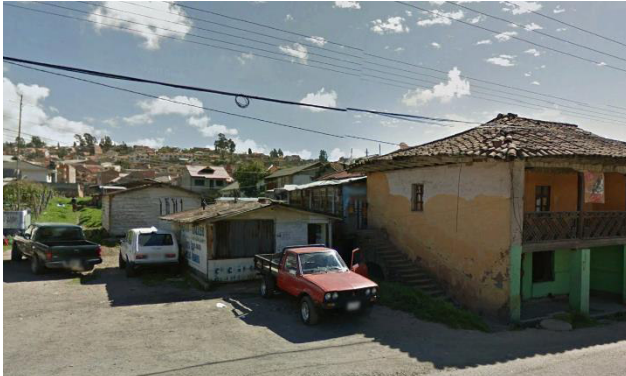
Imagen 68 Edificación 2 antes de la intervención en la Av. Ordóñez Lazo, 2015 Fuente: Fotografía Google Earth, 2015
