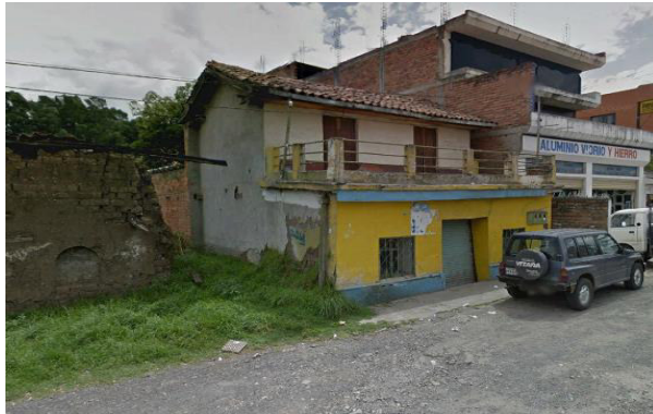
Imagen 93 Edificación 26 antes de la intervención en la Av. Ordóñez Lazo, 2015 Fuente: Fotografía Google Earth, 2015
