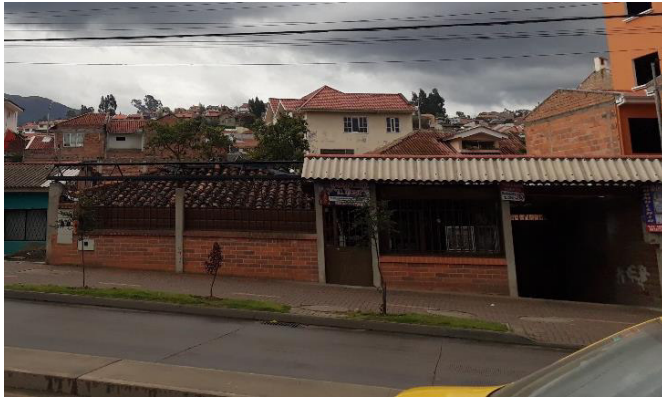
Imagen 49 Edificación 6 estado actual, 2018 Elaboración: María Paz González Durán
