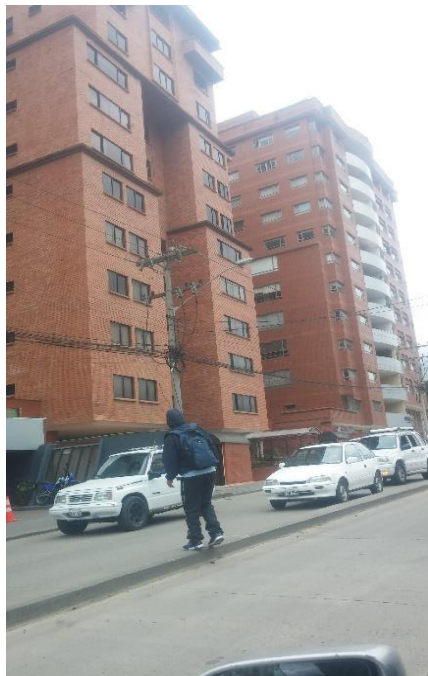
Imagen 17 V.1 Edificación de 12 pisos en la Av. Ordóñez Lazo Elaboración: María Paz González Durán
