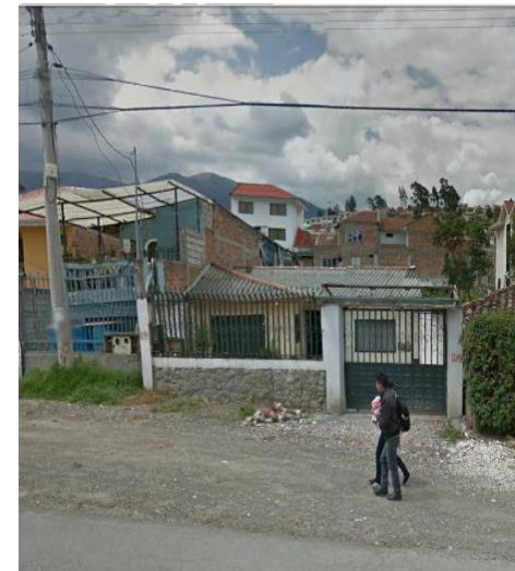
Imagen 48 Edificación 6 antes de la intervención en la Av. Ordóñez Lazo, 2015 Fuente: Fotografía Google Earth, 2015
