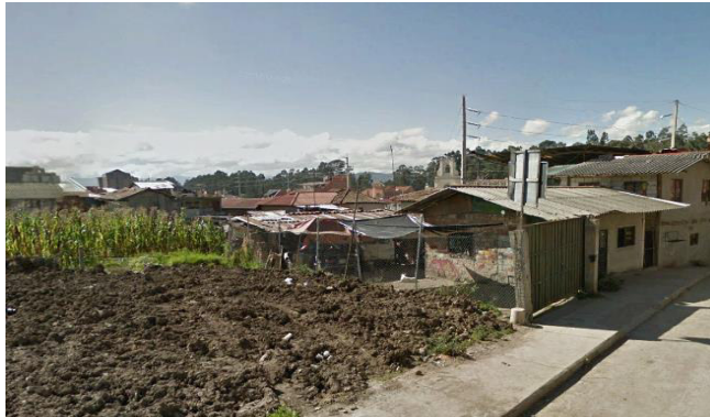
Imagen 79 Edificación 13 antes de la intervención en la Av. Ordóñez Lazo, 2015 Fuente: Fotografía Google Earth, 2015
