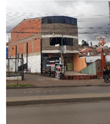
Imagen 53 Edificación 10 estado actual, 2018 Elaboración: María Paz González Durán
