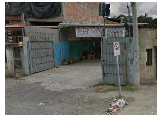
Imagen 91 Edificación 6 antes de la intervención en la Av. Ordóñez Lazo, 2015
