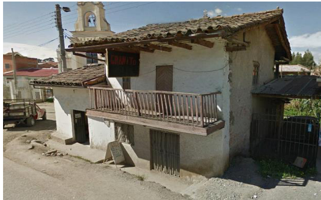
Imagen 89 Edificación 2 antes de la intervención en la Av. Ordóñez Lazo, 2015 Fuente: Fotografía Google Earth, 2015
