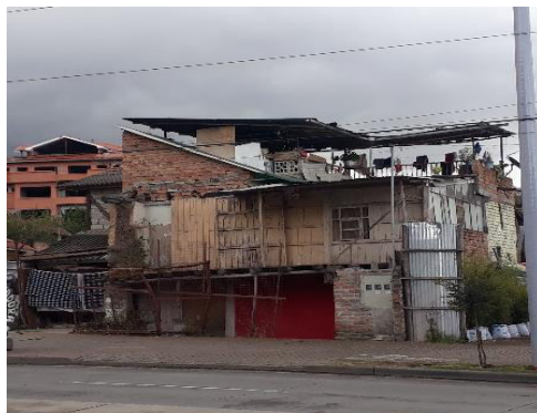
Imagen 76 Edificación 10 estado actual, 2018 Elaboración: María Paz González Durán
