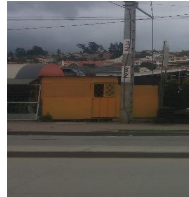
Imagen 73 Edificación 8 estado actual, 2018 Elaboración: María Paz González Durán
