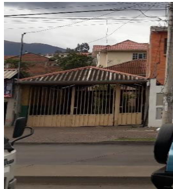
Imagen 47 Edificación 5 estado actual, 2018 Elaboración: María Paz González Durán
