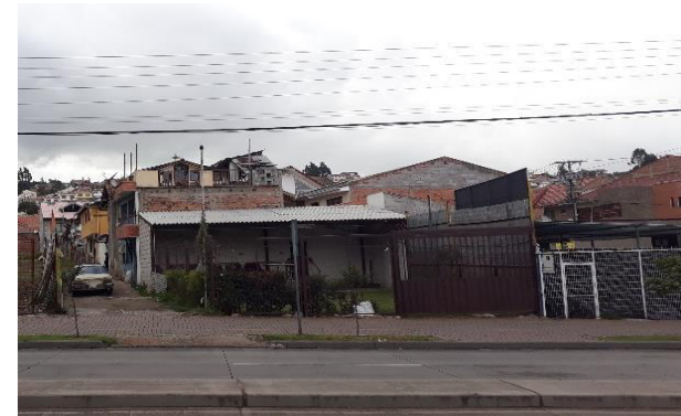
Imagen 67 Edificación 1 estado actual, 2018 Elaboración: María Paz González Durán
