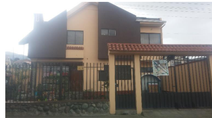
Imagen 65 Edificación 13 estado actual, 2018 Elaboración: María Paz González Durán
