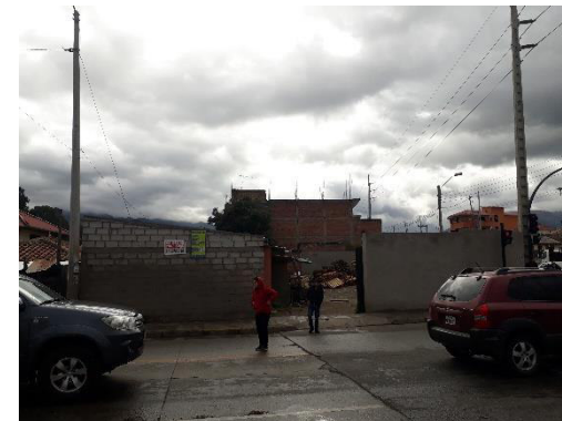
Imagen 96 Edificación 27 estado actual, 2018 Elaboración: María Paz González Durán
