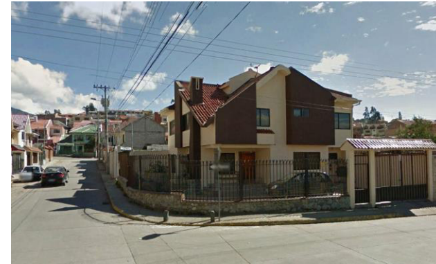
Imagen 64 Edificación 13 antes de la intervención en la Av. Ordóñez Lazo, 2015 Fuente: Fotografía Google Earth, 2015
