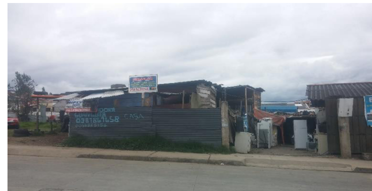
Imagen 82 Edificación 14 estado actual, 2018 Elaboración: María Paz González Durán
