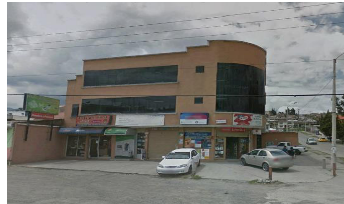
Imagen 39 Edificación 1 estado actual, 2018
