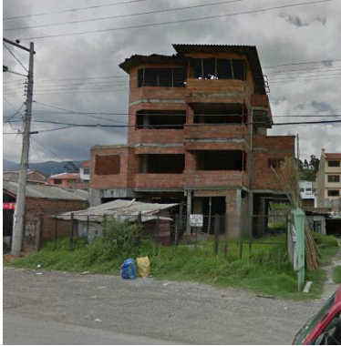
Imagen 44 Edificación 4 antes de la intervención en la Av. Ordóñez Lazo, 2015 Fuente: Fotografía Google Earth, 2015
