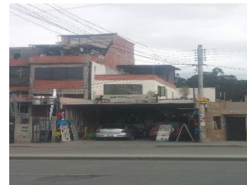
Imagen 92 Edificación 6 estado actual, 2018 Elaboración: María Paz González Durán
