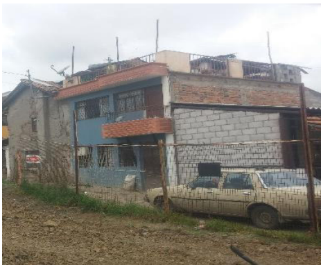
Imagen 69 Edificación 2 estado actual, 2018 Elaboración: María Paz González Durán
