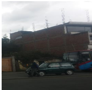
Imagen 94 Edificación 26 estado actual, 2018 Elaboración: María Paz González Durán
