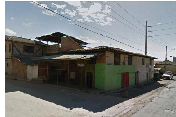
Imagen 77 Edificación 11 antes de la intervención en la Av. Ordóñez Lazo, 2015 Fuente: Fotografía Google Earth, 2015
