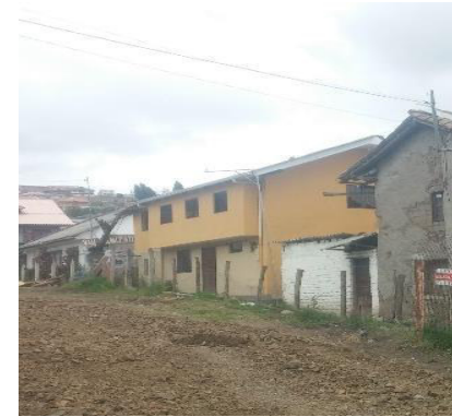
Imagen 70 Edificación 6 estado actual, 2018 Elaboración: María Paz González Durán
