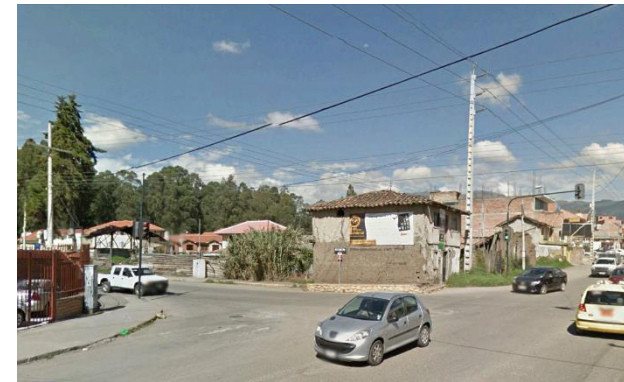
Imagen 95 Edificación 27 antes de la intervención en la Av. Ordóñez Lazo, 2015 Fuente: Fotografía Google Earth, 2015
