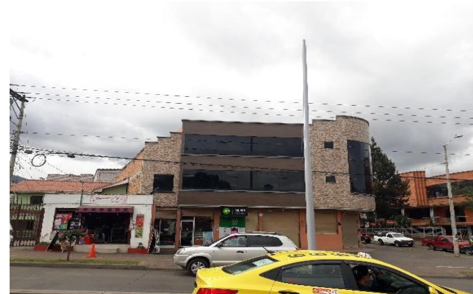
Imagen 38 Edificación 1 antes de la intervención en la Av. Ordóñez Lazo, 2015
