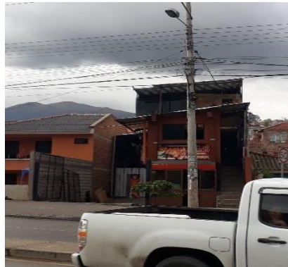
Imagen 51 Edificación 8 estado actual, 2018 Elaboración: María Paz González Durán
