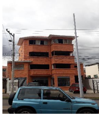
Imagen 45 Edificación 4 estado actual, 2018 Elaboración: María Paz González Durán
