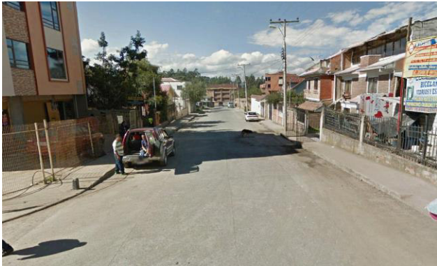
Imagen 87 Calle de la Buganvilla antes de la intervención en la Av. del Tejar, 2015 Fuente: Fotografía Google Earth, 2015
