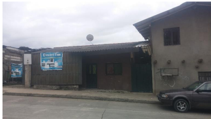
Imagen 80 Edificación 13 estado actual, 2018 Elaboración: María Paz González Durán
