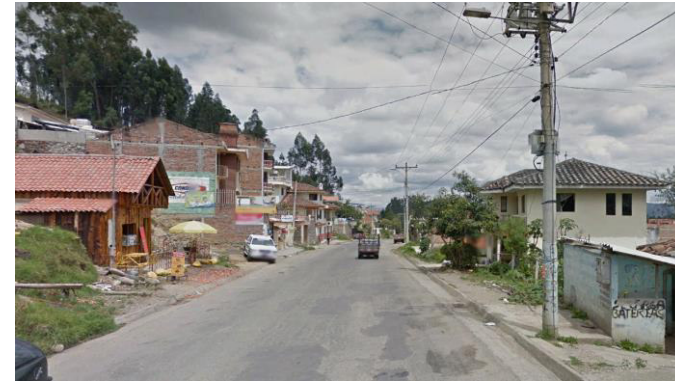
Imagen 3 Estado antes de la intervención de la Av. Ordóñez Lazo desde Intersección Medio Ejido- Sayausí hacia la Av. De las Américas Fuente: Google Earth, 2015 Elaboración: María Paz González Durán
