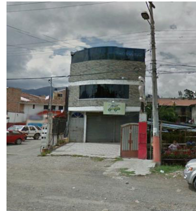
Imagen 52 Edificación 10 antes de la intervención en la Av. Ordóñez Lazo, 2015 Fuente: Fotografía Google Earth, 2015
