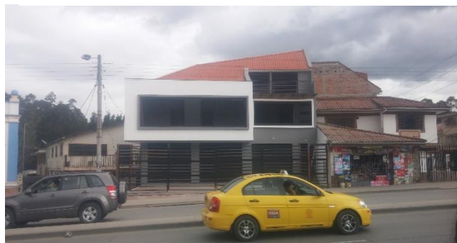
Imagen 90 Edificación 2 estado actual, 2018 Elaboración: María Paz González Durán
