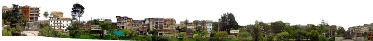
FIGURA 2.24: Visual desde la cota inferior. Tramo 1. Puente el Centenario - Puente Vivas Nos Queremos. Fuente: Fundación El Barranco.
