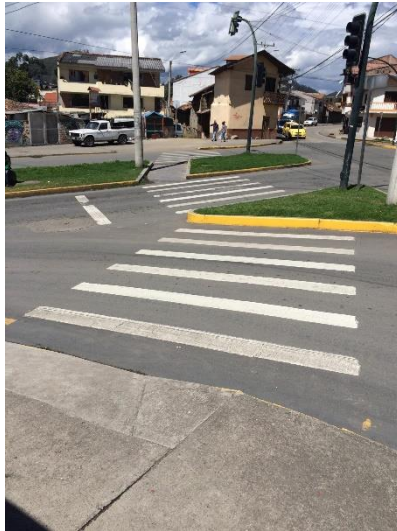
Ilustración 381: Adecuado nivel de rugosidad en la Av. Primero de Mayo. Fuente: La autora.
