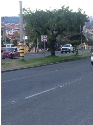
Ilustración 364: Nivel adecuado de rugosidad en la Av. De las Américas. Fuente: La autora.
