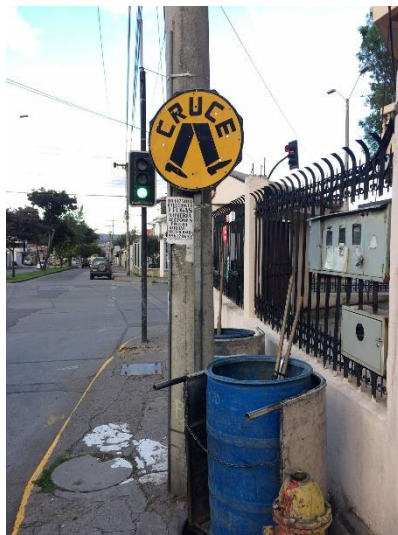
Ilustración 424: Letrero amarrado de cruce peatonal en la Calle Vieja sentido Oeste - Este. Fuente: La autora.
