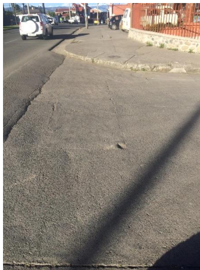
Ilustración 325: Adecuado nivel de rugosidad en la Francisco Tamaríz. Fuente: La autora.
