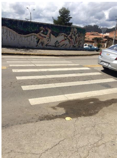
Ilustración 382: Adecuado nivel de rugosidad en la Av. Loja. Fuente: La autora.
