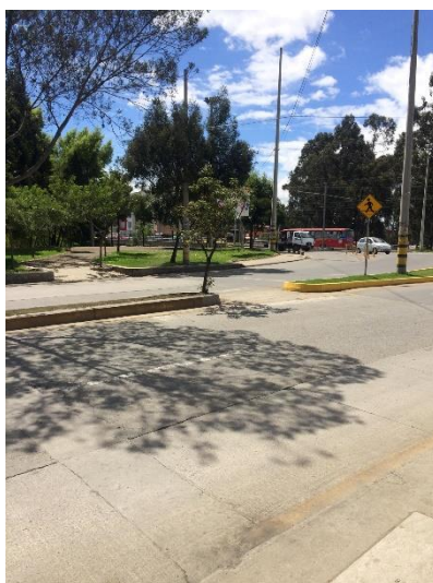
Ilustración 429: Señalización horizontal inexistente en la Av. Primero de Mayo sentido Oeste - Este. Fuente: La autora.
