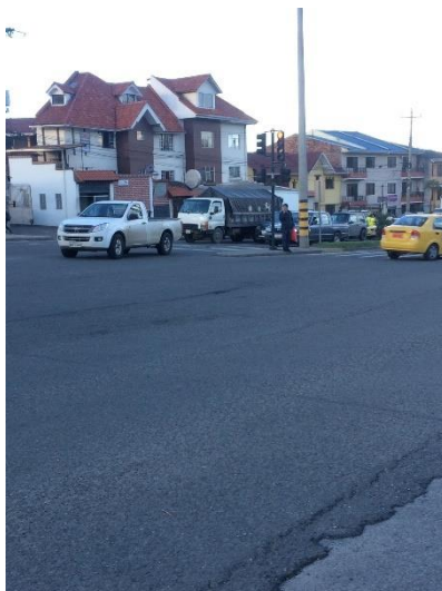
Ilustración 312: Adecuado nivel de rugosidad Av. De las Américas Fuente: La autora
