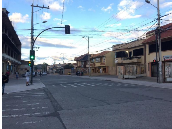
Ilustración 386: Fisuras selladas en la Av. Don Bosco. Fuente: La autora.
