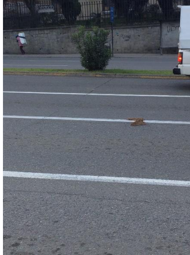
Ilustración 356: Adecuado nivel de rugosidad en la Av. De las Américas sentido Oeste - Este. Fuente: La autora.
