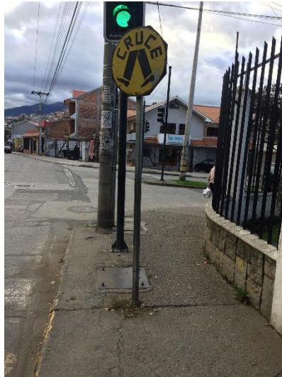
Ilustración 425: Letrero desgastado de cruce peatonal en la Turhuayco sentido Sur - Norte. Fuente: La autora.
