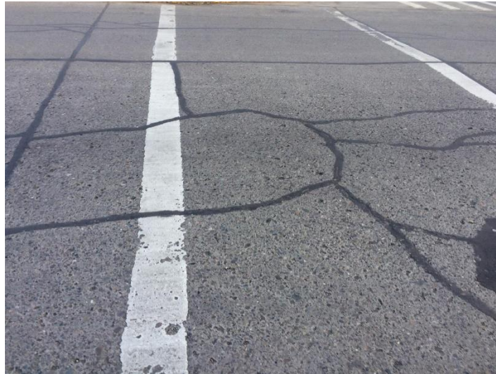
Ilustración 377: Fisuras selladas en la Av. Don Bosco. Fuente: La autora.
