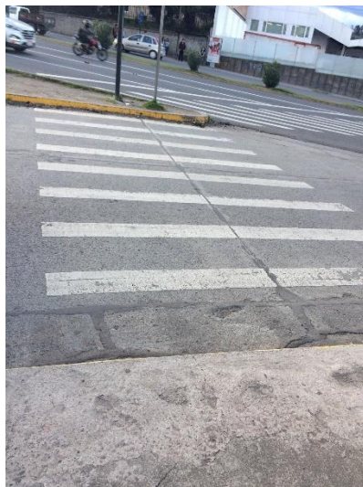
Ilustración 416: Cruce peatonal en la calle Obispo Miguel León sentido Sur - Norte. Fuente: La autora.
