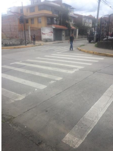
Ilustración 399: Cruce peatonal en la Av. Héroes de Verdeloma sentido Este - Oeste. Fuente: La autora.
