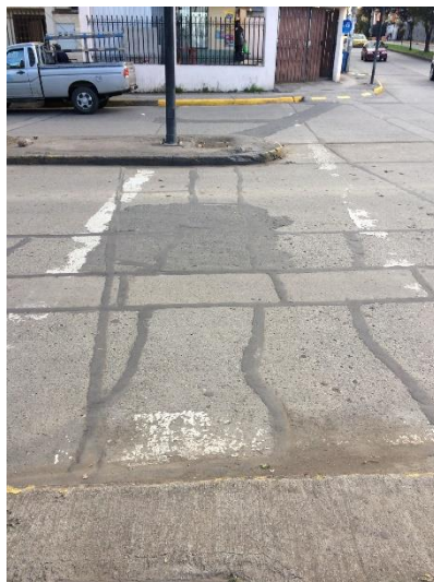
Ilustración 369: Nivel adecuado de rugosidad en la Turuhuayco.
