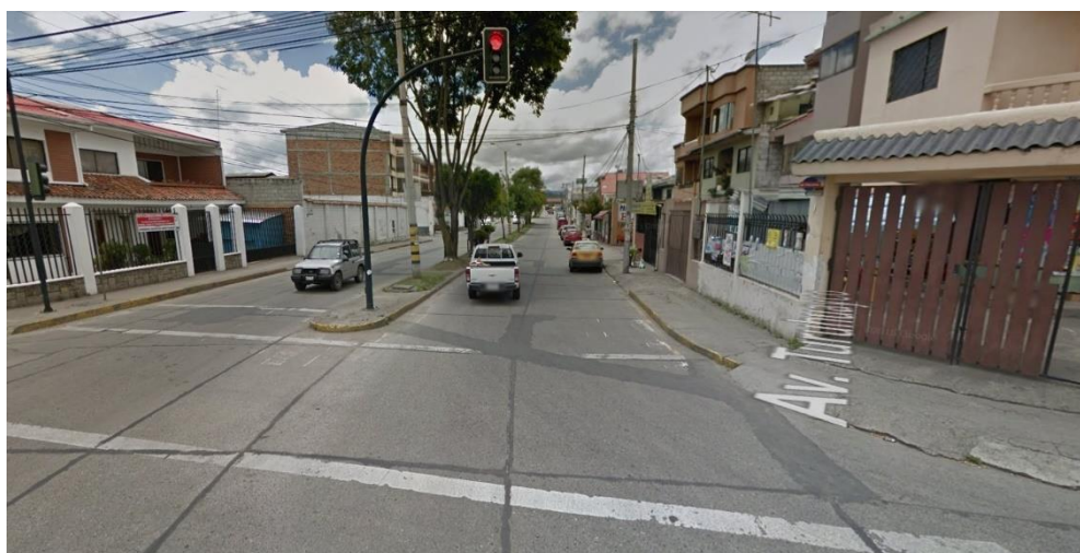
Ilustración 211: Turuhuayco sentido Sur - Norte Fuente: Google Maps
