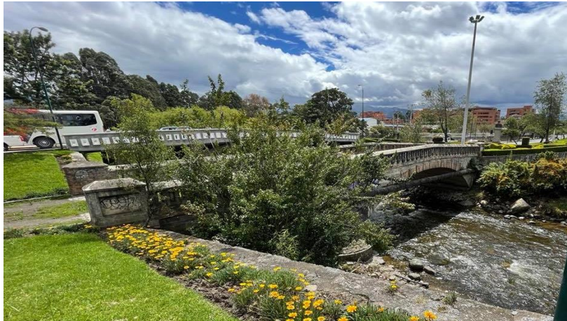
Ilustración 3. 14. Puente "Tres Puentes"
