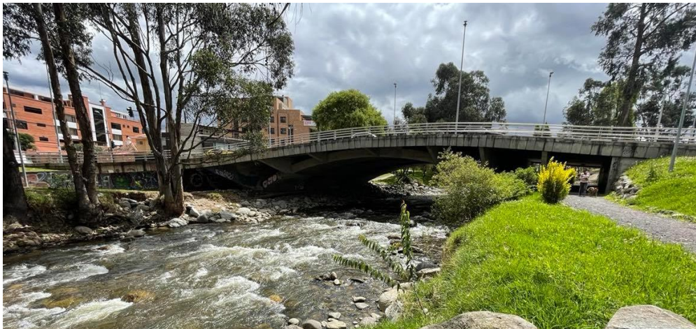
Ilustración 3. 12 Puente Felipe II
