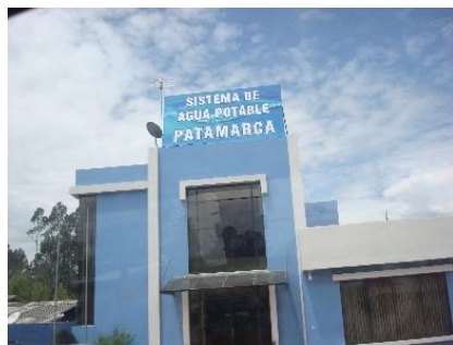
Foto N. 42. Referencia Planta de Agua Potable.
