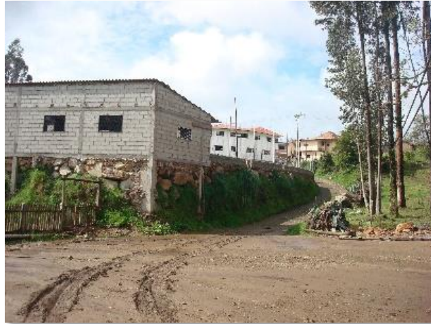
Foto N. 32. Acceso desde la vía principal a la explanada.
