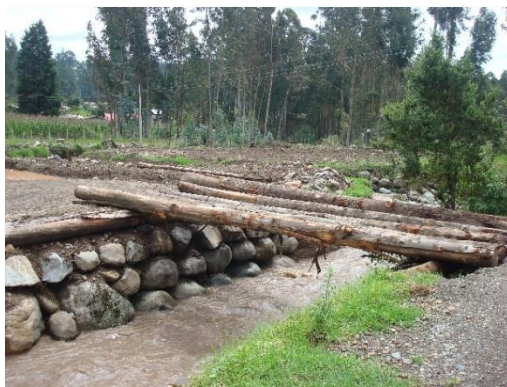
Foto N. 36. Puente provisional de cruce del río Quintul.
