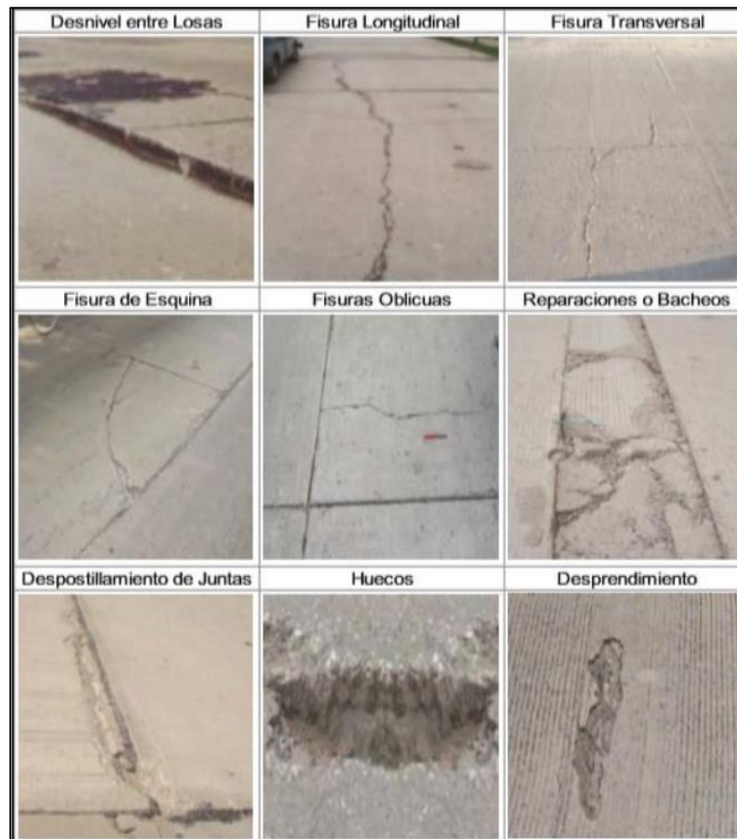
Gráfica 9. Daños en pavimentos rígidos
