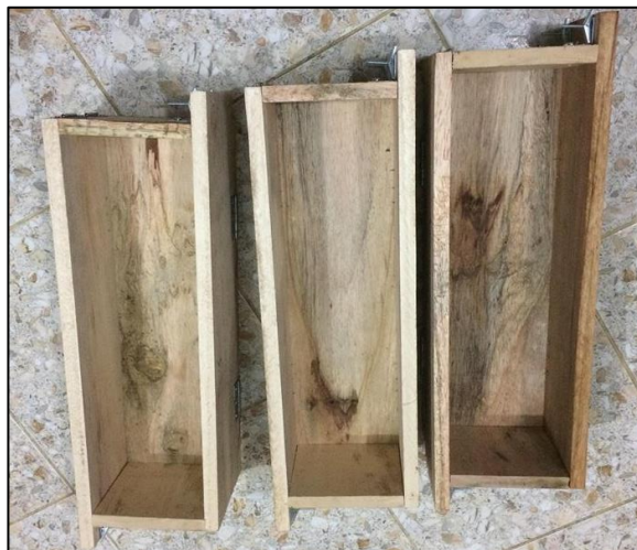
Ilustración 16 Encofrado de vigas de 15x15x53 cm
