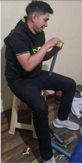
*Sacar rosca a las tuberías y colocación de teflón.*
