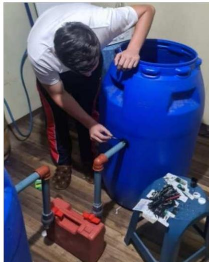
*Figura 22: Construcción del sistema de evacuación de lixiviado.
