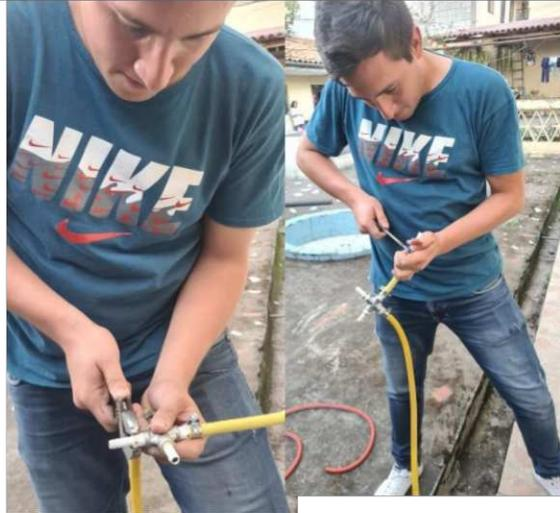
Colocación de conectores tipo espigas las cuales unen a la cruz con las mangueras.
