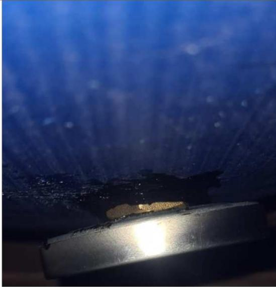
Colocación de Pegatanke en la unión tanque-termómetro, con la finalidad de evitar fuga de biogás así como de materia orgánica o lixiviado.
