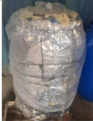
Colocación de lana de vidrio en un solo tanque para aislar térmicamente.
