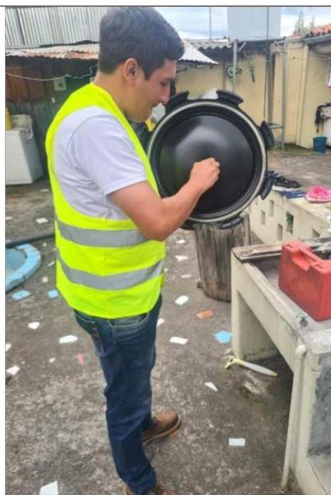
Colocación de Pegatanke para asegurar las uniones y en especial la unión neplo - tapa de tanque.
