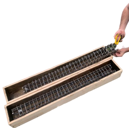
Figura 23 Encontrado y la armadura de acero con su distribución.
