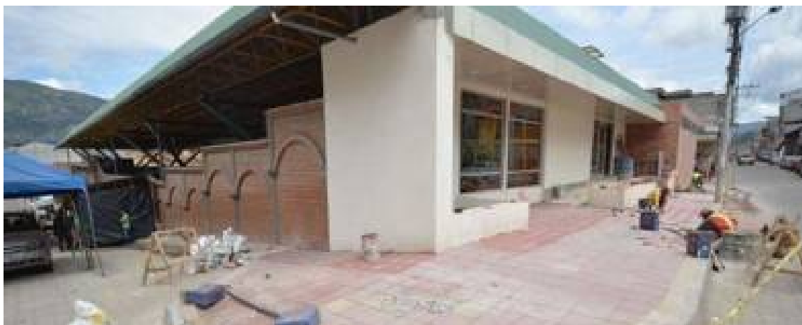
Figura 2.1.9: Fachada hacia la calle Guayaquil.
