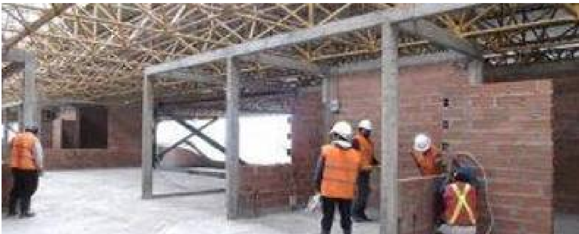
Figura 2.1.8: Construcción segunda planta. Fuente: (ComisarioMunicipal,2019) Recuperado: 01/12/2019
