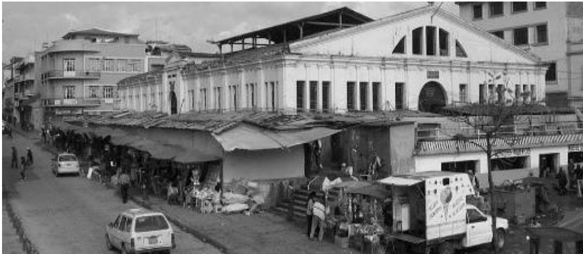
Figura 1.3.1: Mercado Municipal 9 de Octubre antes de la regeneración urbana. Fuente: http://www.arquitecturapanamericana.com/rehabilitacion-del-mercado-9-de-octubre/ Recuperado: 04/11/2019
