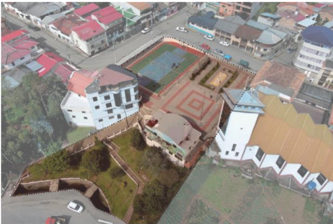
Figura 24: Vista aérea – Área de Emplazamiento
