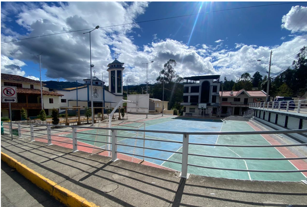
Figura 26: Vista Lateral Izquierda – Calle Eloy Riera.
