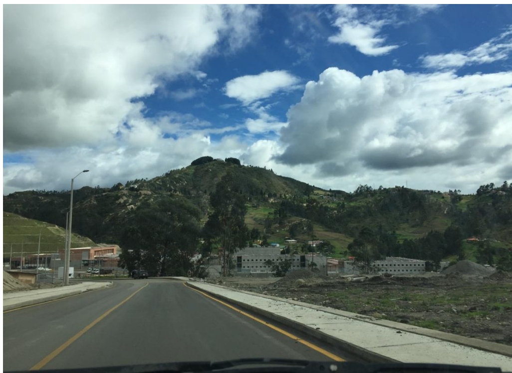
Fotografía N° 14: Vía al centro de rehabilitación social
