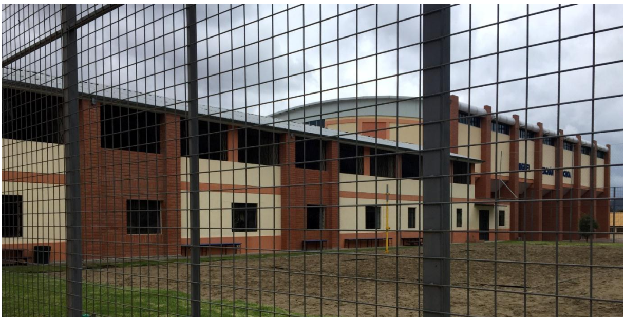
Fotografía N° 10: Antiguos Dormitorios “Centro Neocatecumenal”
