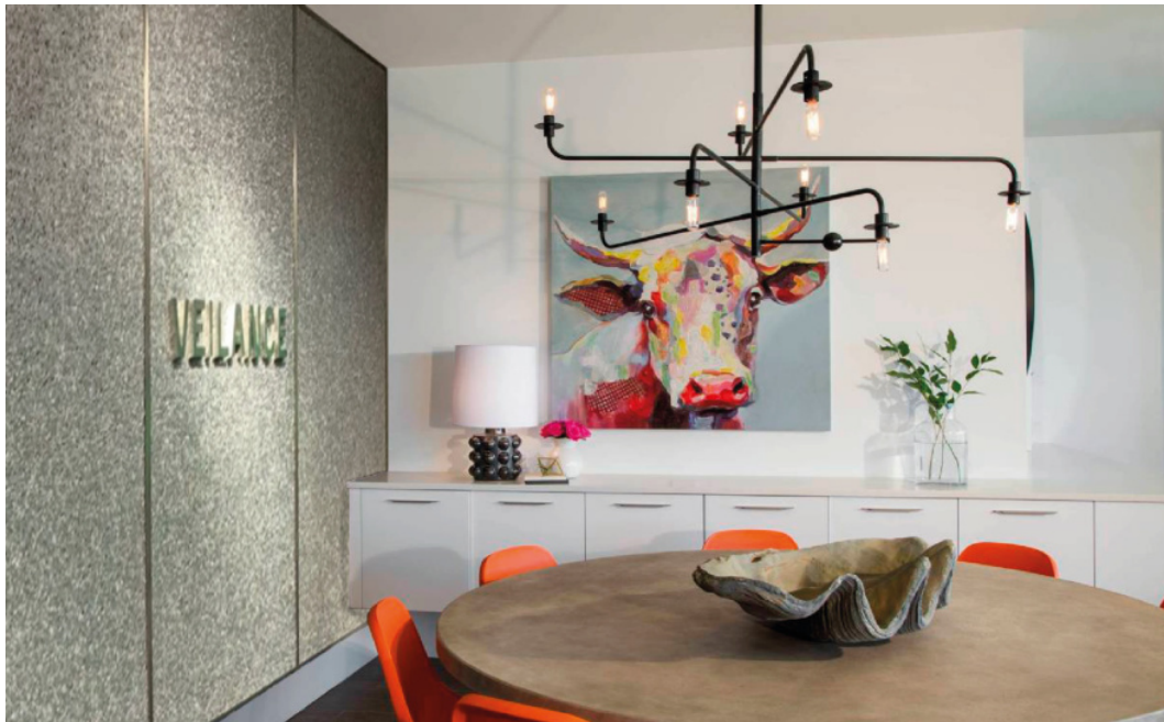
Figura 3.39: Uso de panel de aluminio reciclado en mampostería interior
