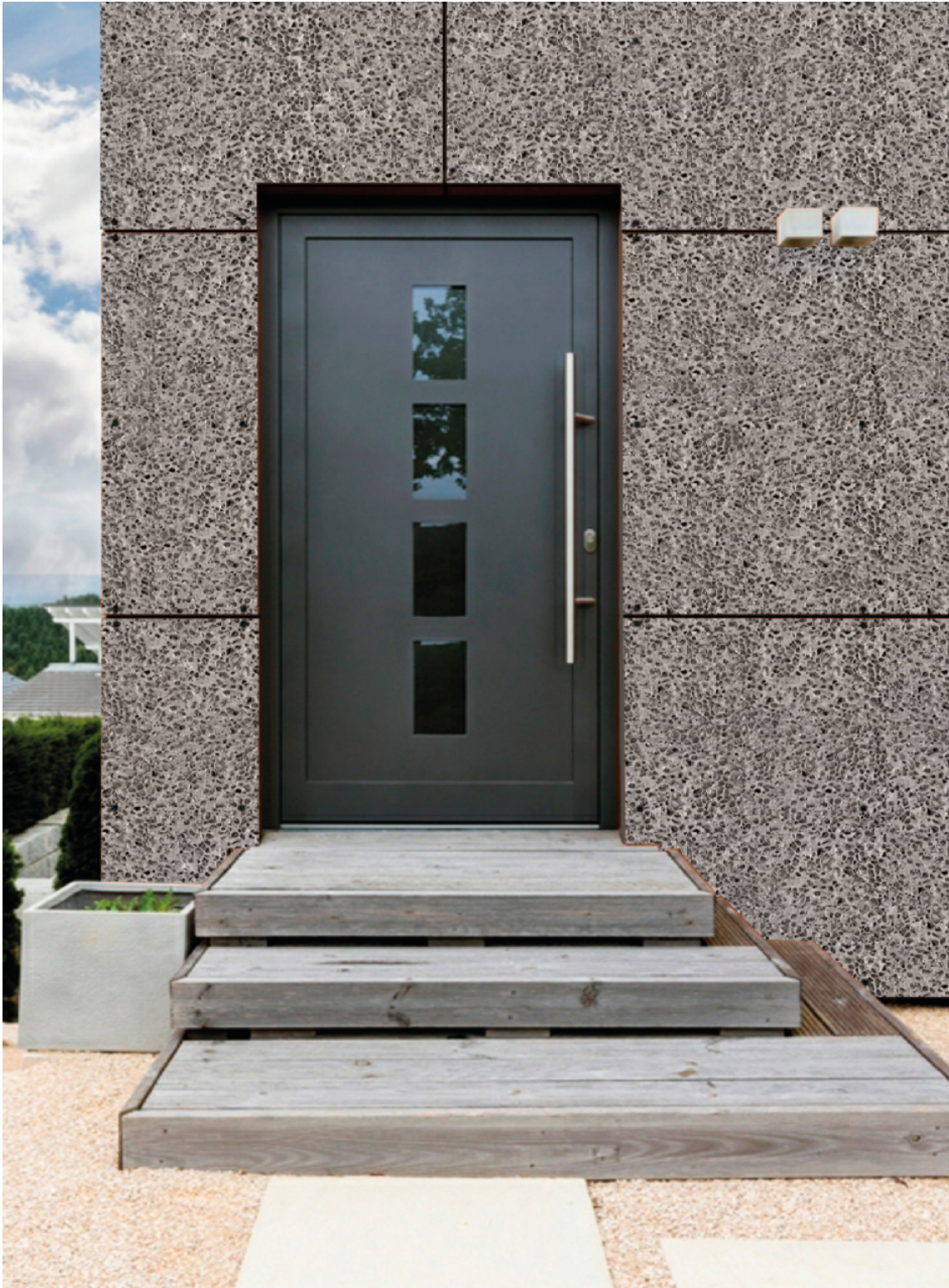
Figura 3.35: Uso de panel de aluminio reciclado en revestimiento exterior
