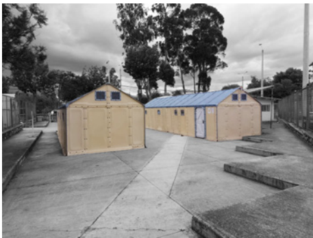
FIGURA 3.86: Emplazamiento de RHU simple en el Hospital Vicente Corral Moscoso, Cuenca. Fuente y elaboración: Autores.
