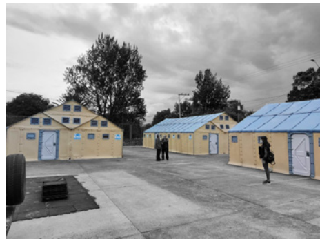
FIGURA 3.87: Emplazamiento de RHU doble en el Hospital Vicente Corral Moscoso, Cuenca. Fuente y elaboración: Autores.
