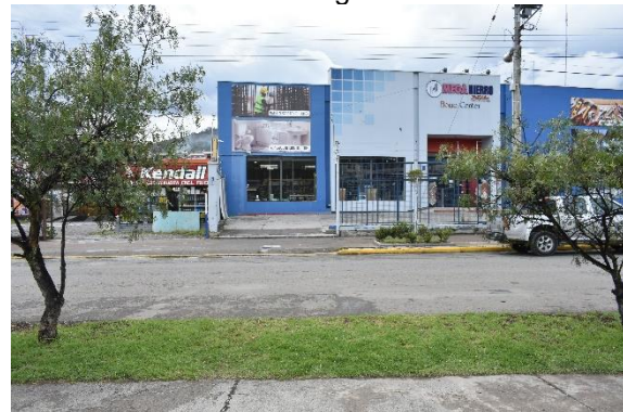
Figura 46. Visual 4 – entorno construido norte Elaboración: Valeria Ortega
