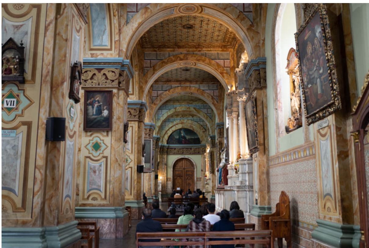
FIGURA 3.25: Estructura e instalaciones con alta carga de combustión. Fuente: Ayala & Pulla (2022) .
