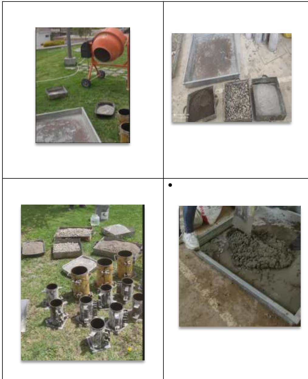
Ilustración 21: Elaboración de hormigón
