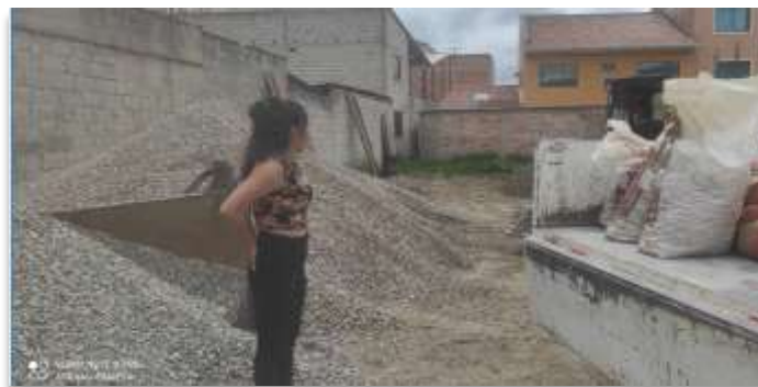
Ilustración 15: Materiales agregados para la mezcla de hormigón
