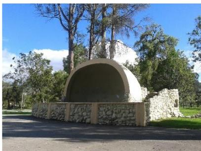
Materiales predominantes: Muros de piedra y cubierta hormigón armado.
