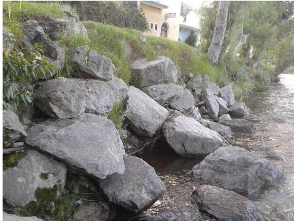
Figura 46. Enrocado de muros de contención
