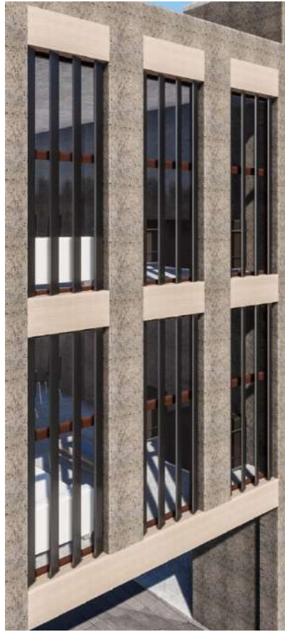
FIGURA 4.27: Lamas fachada oeste. Elaboración: Jiménez y Coronel (2020)
