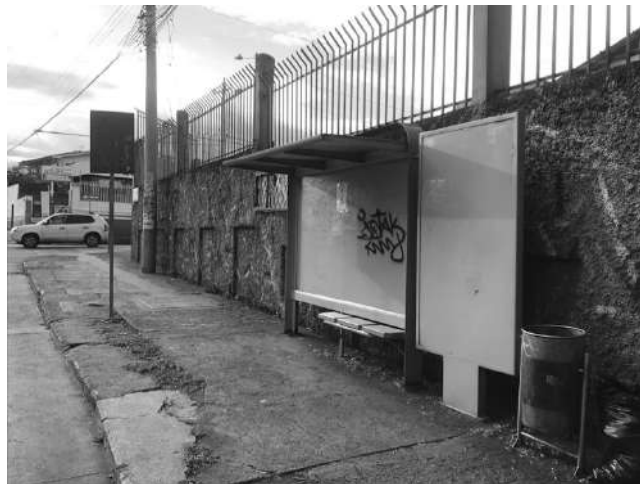
FIGURA 2.64: Estado de parada de bus.
