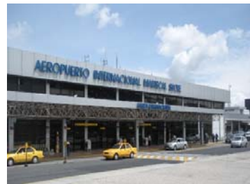
Imagen 24 –Aeropuerto Mariscal Sucre, Smith Engineering. Fuente: El Comercio (2015).
