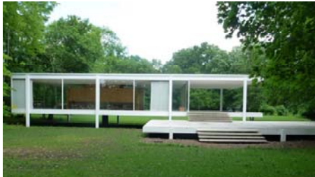
Imagen 13 – Casa Farnsworth. Fuente: Tuxboard (s.f.).
