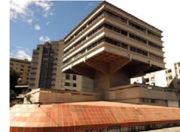
Imagen 25 – Edificio CIESPAL, Milton Barragán. Fuente: SEMAICA (S.f.).
