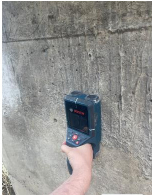
Ilustración 7 Ensayo de Scanner de hierros
