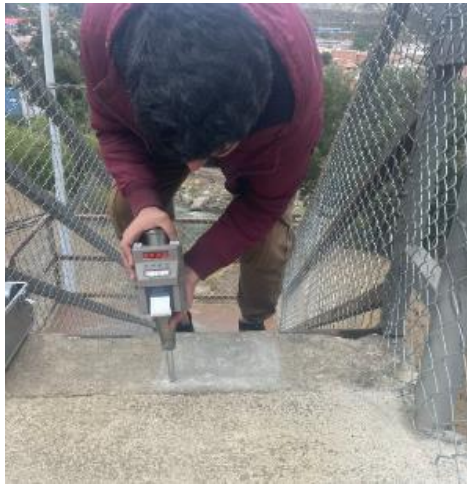
Ilustración 21 Ensayo con Esclerómetro
