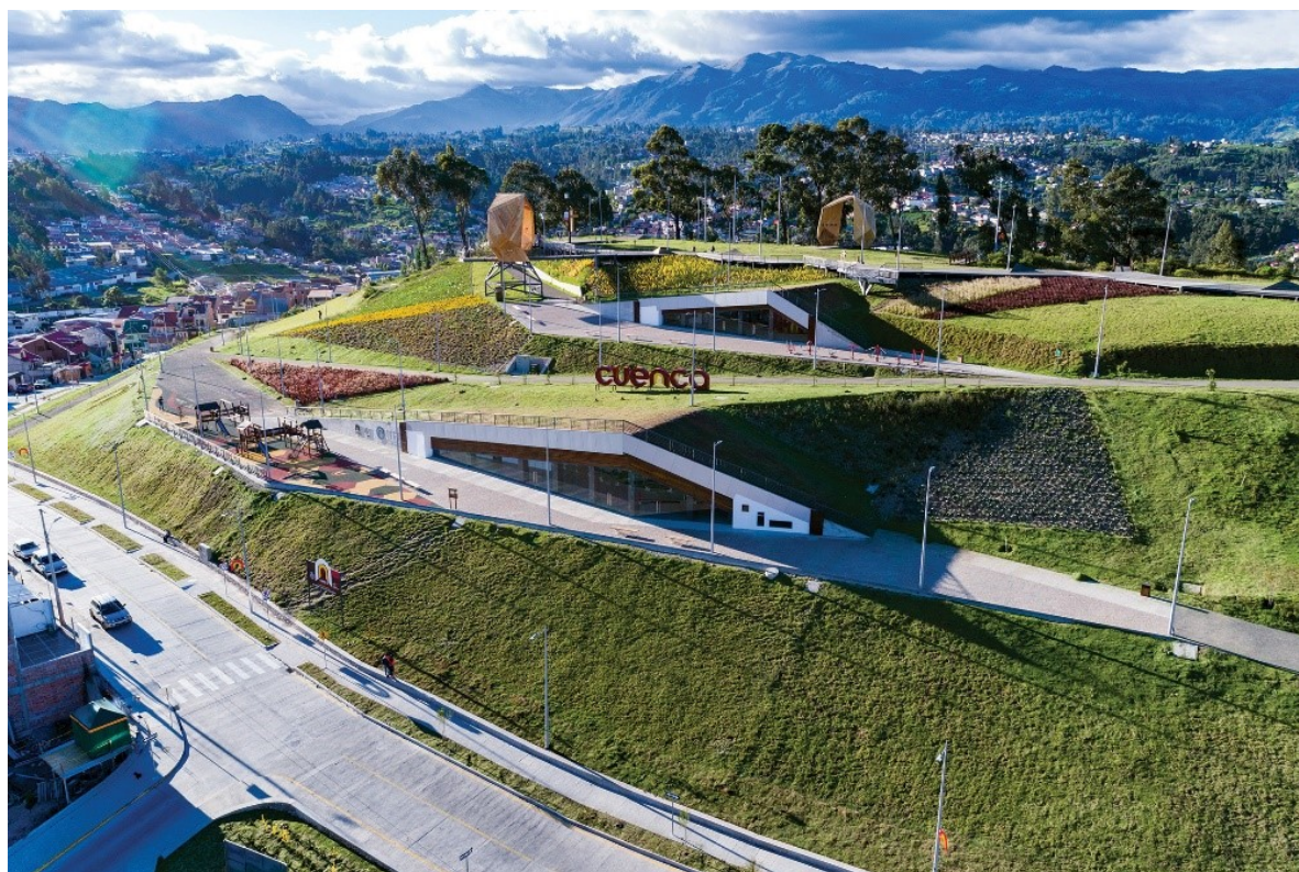
FIGURA 1.10: Espacio público con características urbanas en espacios periféricos. Parque de la Luz, Cuenca.
