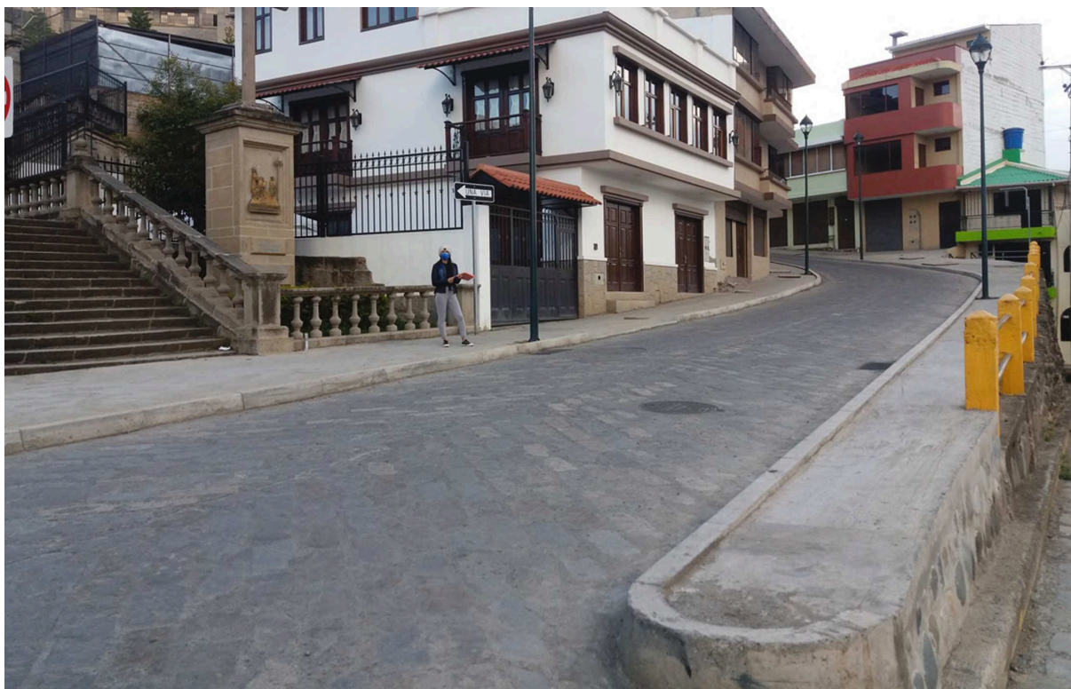
Figura 82: Ausencia de paso peatonal, Calle 4 de Noviembre, Azogues
