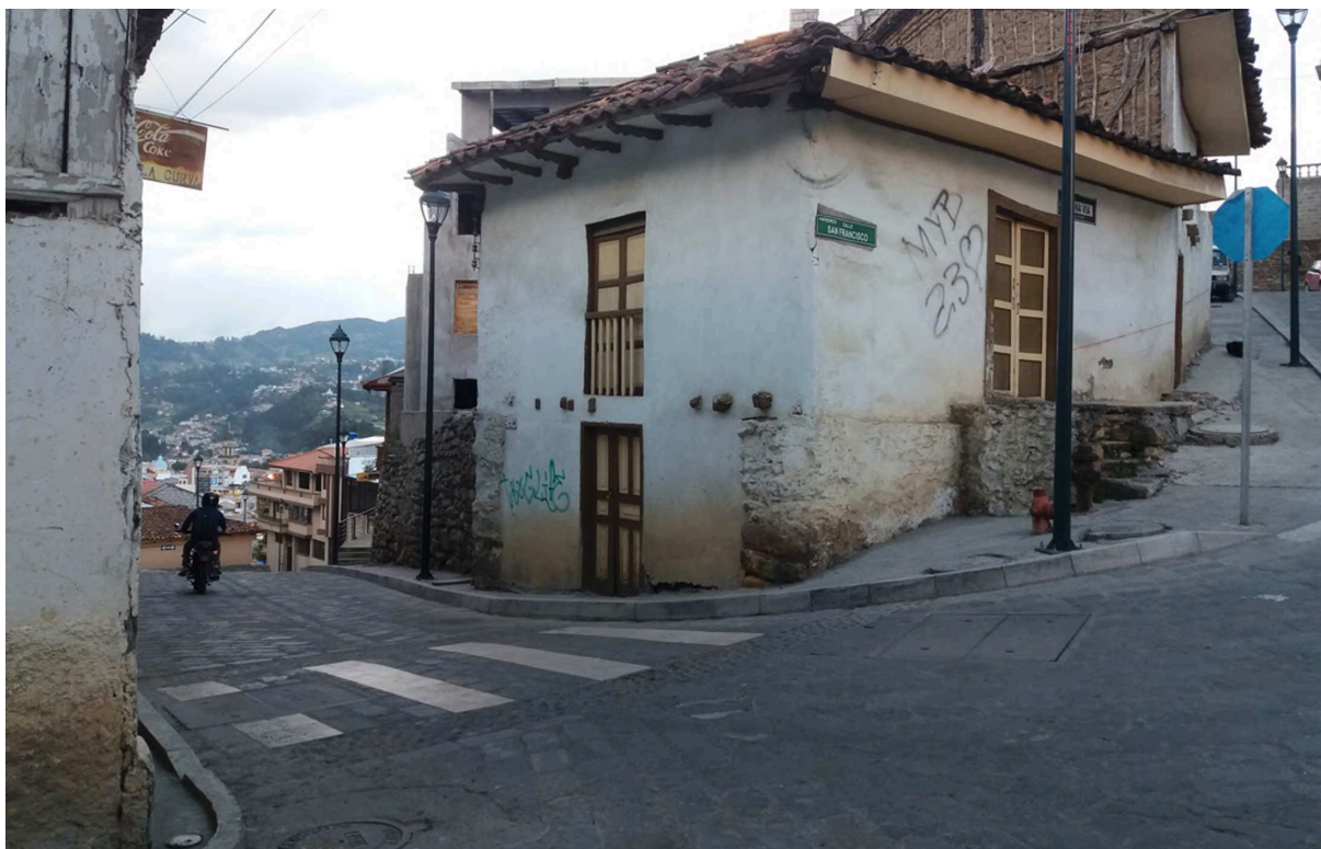
Figura 81: Discontinuidad en el paso peatonal y aceras con dimensionamiento reducido, Calle 4 de Noviembre, Azogues
