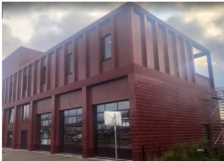
FIGURA 2.67: Fachada actual de la Estación de Bomberos, Wilrijk. Obtenido de: https://n9.cl/vxshc
