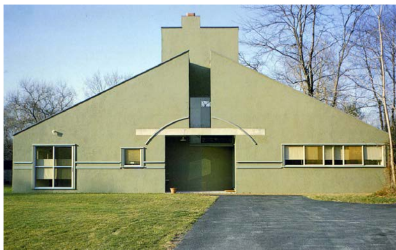
FIGURA 1.18: Fachada Casa Vanna Venturi. Fuente: Fracalossi (2014). Obtenido de: https://n9.cl/sr1lo
