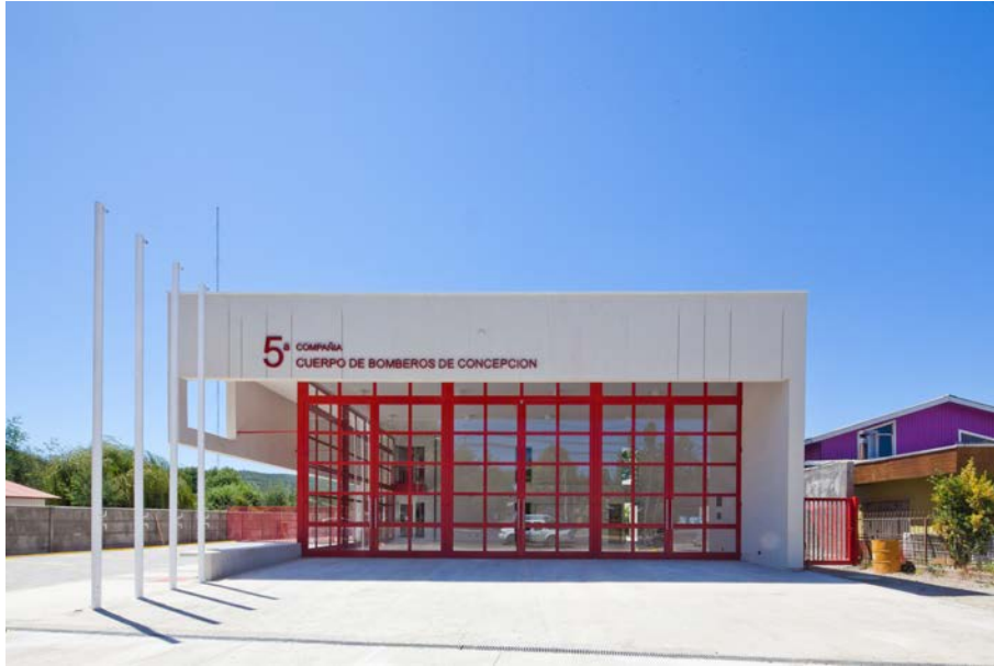
FIGURA 2.1: Estación de Bomberos 5ta compañía de la Concepción, Chile. Fuente: (Andreu Arquitectos, 2012). Obtenido de: https://n9.cl/0akix
