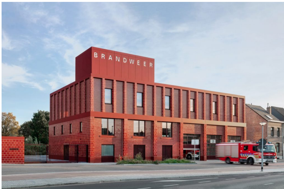
FIGURA 2.47: Visual actual de la Estación de Bomberos Wilrijk, Amberes. Obtenido de: https://n9.cl/t3s7a
