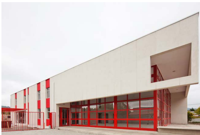
FIGURA 2.3: Estación de Bomberos 5ta compañía de la Concepción, Chile. Fuente: Andreu Arquitectos, 2012. Obtenido de: https://n9.cl/wr64b
