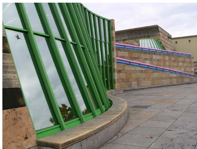
FIGURA 1.24: Neue Staatsgalerie Stuttgart, vista a pasarelas. Fuente: Del Castillo Sánchez (2018). Obtenido de: https://n9.cl/txudj
