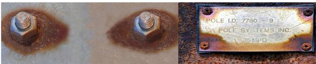
FIGURA 1.3: Corrosión galvánica
