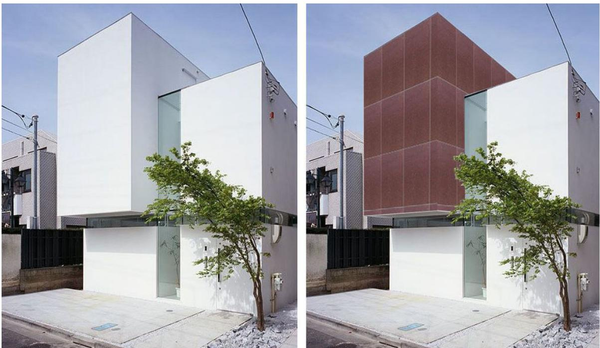
FIGURA 4.25: Empleo de paneles oxidados en fachadas
