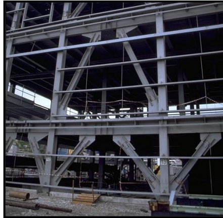
Imagen 1.5: Ejemplos de pórticos con arriostramientos excéntricos.
