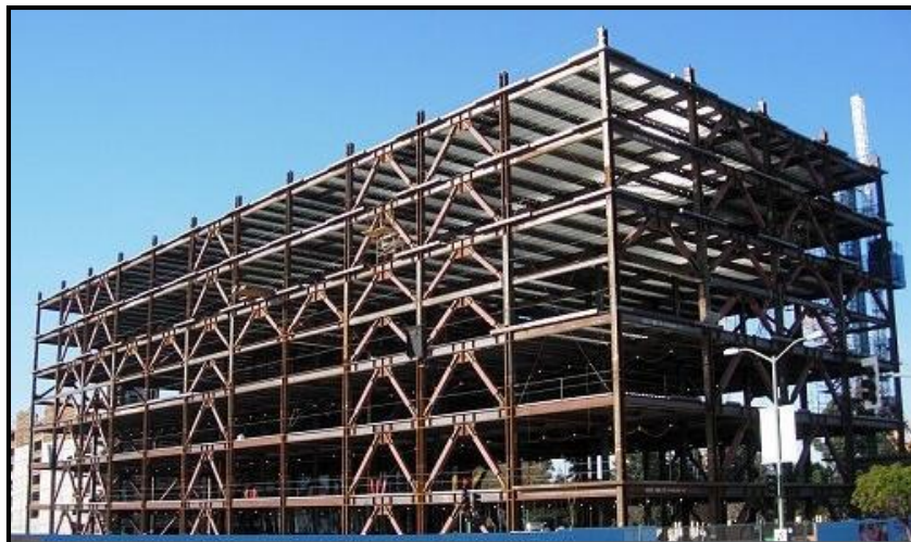
Imagen 1.7: Vista de un edificio en construcción con pórticos arriostrados.
