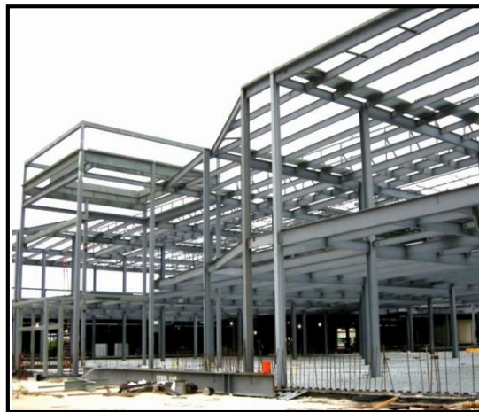
Imagen 1.3: Vista general de una estructura de pórticos no arriostrados para un edificio comercial.
