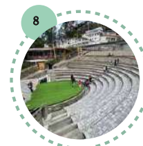
Vista hacia el graderío situado en la parte baja marcando el uso publico para espectáculos.
