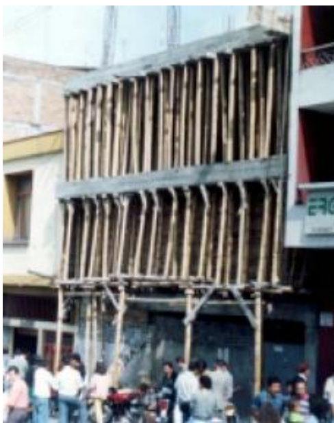
Figura 6 Bambú en obra falsa.
