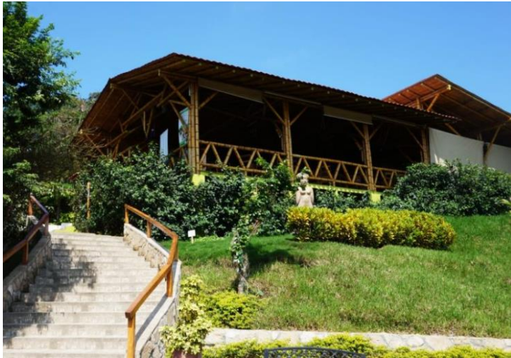
Figura 5 Edificación con bambú.
