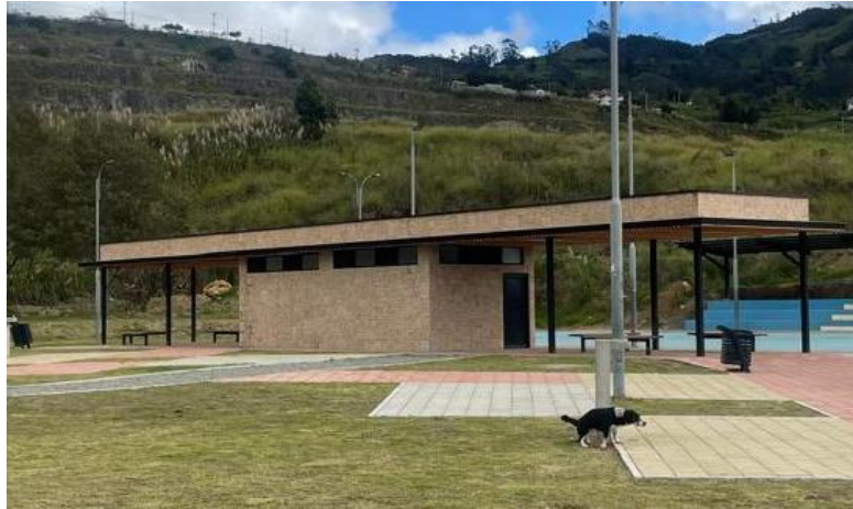
Figura 52: Baños públicos cerrados
