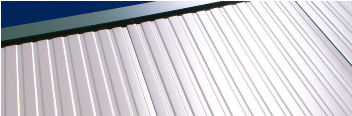
FIGURA 10. CUBIERTA ELABORADA CON CHAPAS DE ALUMINIO. FUENTE: (AYUSO, 2016)
