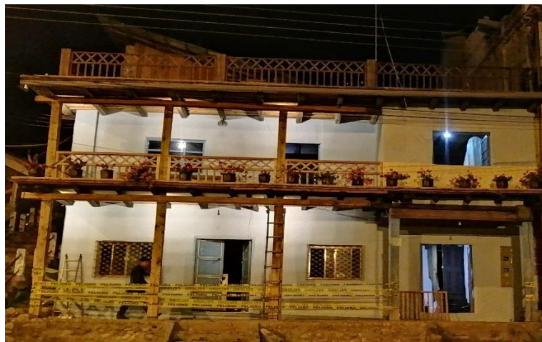
Figura 44: Fachada de casa patrimonial con la iluminación proyectada. Fuente: Rene Brito-Luis Saldaña, autores.
