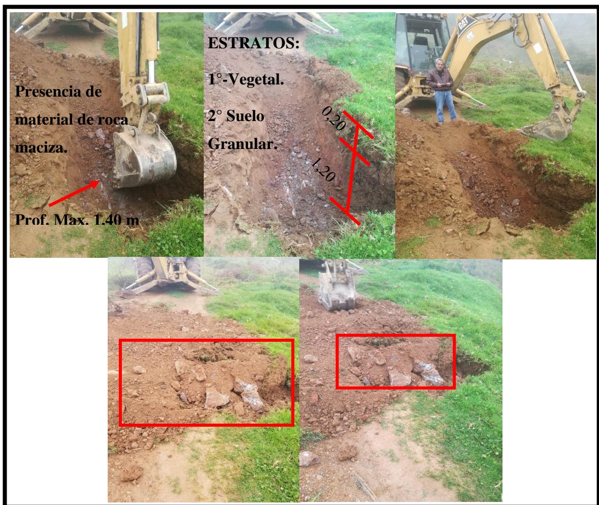
Figura 26: Estrato calicata No. 6 Fuente: Propios autores
