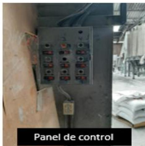
*Imagen 73: Compuerta de Descarga del Secador, Panel de Control del Secador*
