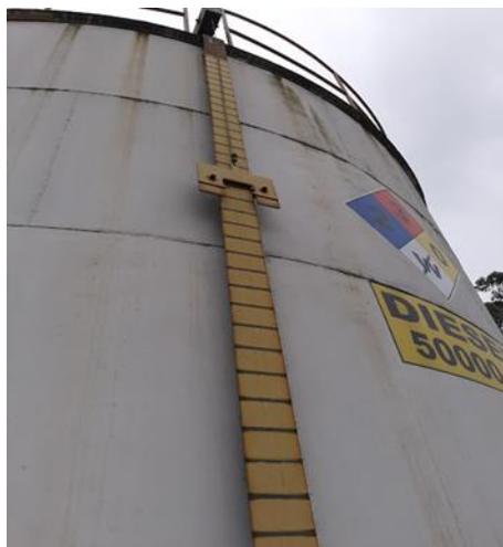
*Imagen 36:* Medidor de Nivel de Combustible
