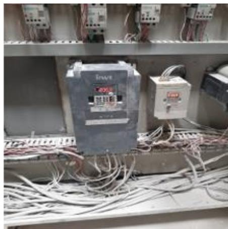
*Imagen 48:* Panel de Control, Variador de Frecuencia
