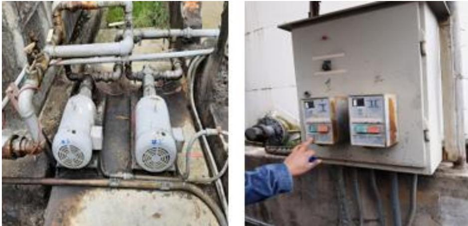
*Imagen 38: Bombas de Diésel, Panel de Control de Bombas*
