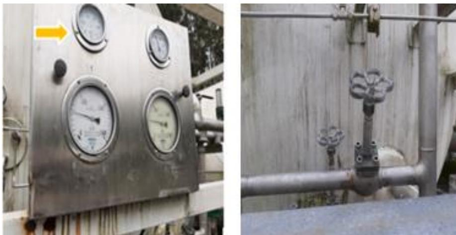
**Imagen 31:** Medidor de Presión, Llave de Desfogue de Presión
