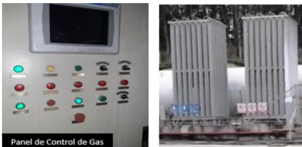
*Imagen 33: Panel de Control Vaporizadores, Vaporizadores*
