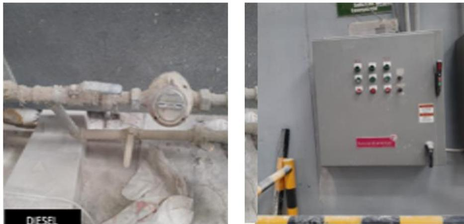
*Imagen 39: Llave de Diésel de Hornos, Panel de Control Turbo*
