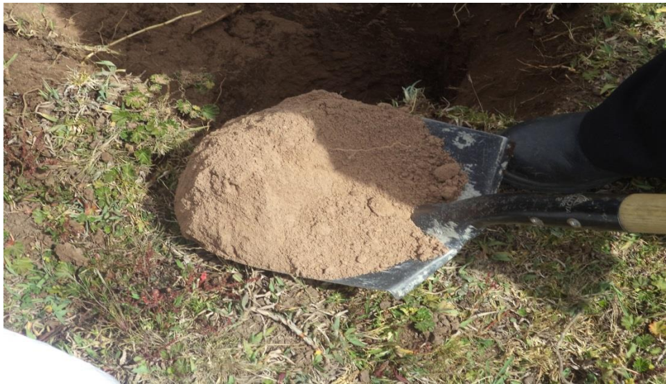
figura 13. Excavación para obtener muestra
