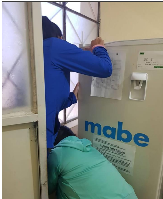
Fig. 17: En esta imagen se puede observar la verificación de la distancia entre la pared y la refrigeradora y esta no se encuentra a 15cm.
