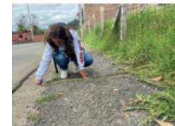
Medición de la acera calle 1 de septiembre .Misicata Fuente: propia.
