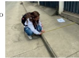
Medición de la acera calle Chordeleg.Misicata Fuente: propia.
