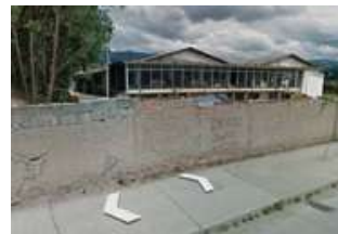
■ ECU 911 Equipamiento Fiscalía del Azuay Fuente: Google Maps
