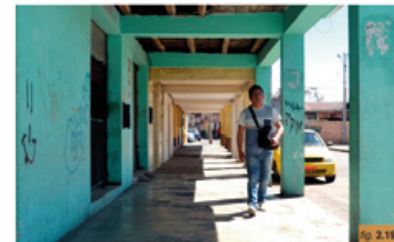
Aceras con dimensiones heterogéneas (tramo2). Aceras con dimensiones óptimas (tramo 3) Fuente: (Herrera, Rodas, 2018).Recuperado el:8/08/2022.
