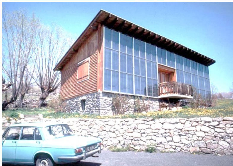
FIGURA 1.5: Primer Muro Trombe experimental. Imagen tomada de http://hiddenarchitecture.net/ungreen-trombe-wall/
