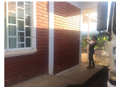
FOTOGRAFÍA N°3.1.9.1.2 Pared de ladrillo
