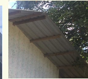
FOTOGRAFÍA N°2.50 Alero de madera
