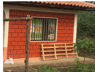
FOTOGRAFÍA N°3.1.8.1.2 Pared de ladrillo
