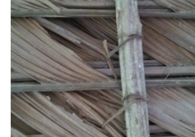
FOTOGRAFÍA N°3.1.2.1.3 Cubierta de Palma
