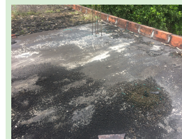
FOTOGRAFÍA N°3.1.4.1.3 Cubierta de Hormigón
