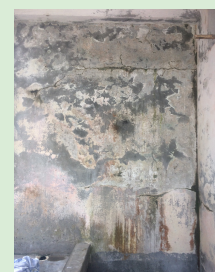
FOTOGRAFÍA N°3.1.4.1.2 Pared de bloque
