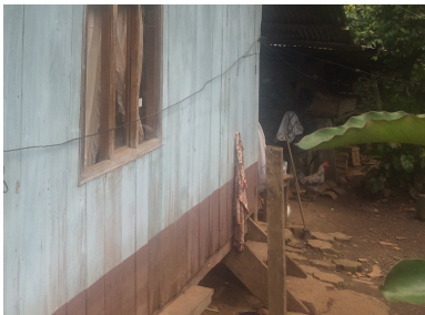
FOTOGRAFÍA N°3.1.10.1.1 Suelo de madera
