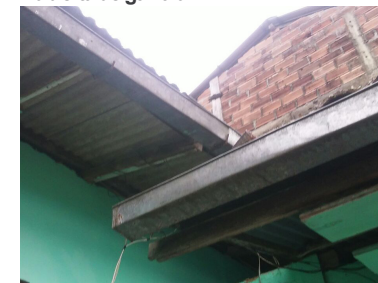
FOTOGRAFÍA N°3.1.11.1.3 Cubierta de galvalum
