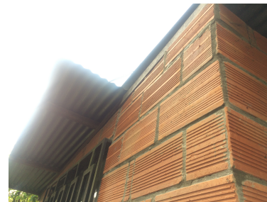
FOTOGRAFÍA N°3.1.6.1.2 Pared de ladrillo
