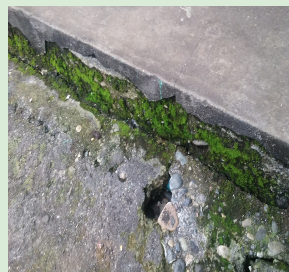
FOTOGRAFÍA N°3.1.4.1.1 Suelo de cemento
