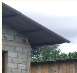
FOTOGRAFÍA N°2.46 Pared de bloque
