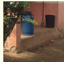
FOTOGRAFÍA N°2.47 Piso de hormigón
