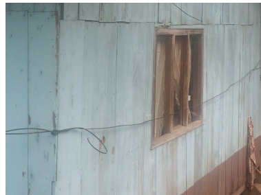
FOTOGRAFÍA N°3.1.10.1.2 Pared de madera
