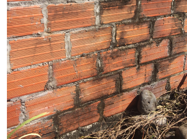
FOTOGRAFÍA N°3.1.2.1.2 Pared de ladrillo tochada
