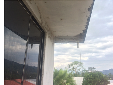
FOTOGRAFÍA N°3.1.4.1.2 Pared de ladrillo y bloque
