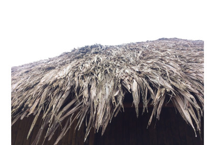
FOTOGRAFÍA N°3.1.1.1.3 Cubierta de Palma
