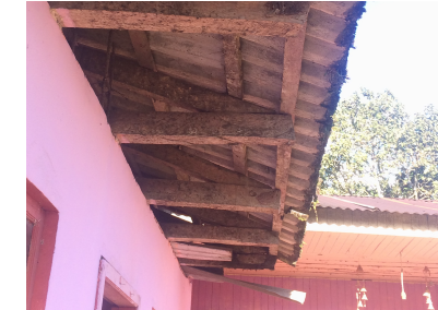
FOTOGRAFÍA N°3.1.7.1.3 Cubierta de teja
