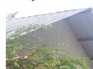
FOTOGRAFÍA N°3.1.5.1.3 Cubierta de galvalum
