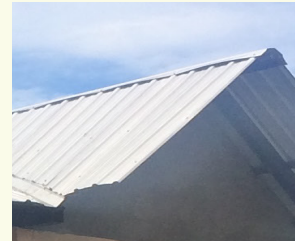
FOTOGRAFÍA N°2.49 Recubrimiento de cubierta galvalume
