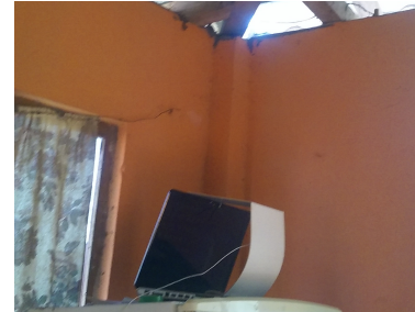
FOTOGRAFÍA N°3.1.7.1.2 Pared de bloque
