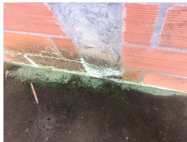
FOTOGRAFÍA N°3.1.8.1.1 Suelo de cemento
