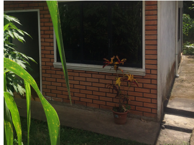
FOTOGRAFÍA N°3.1.4.1.1 Suelo de cemento
