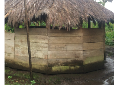
FOTOGRAFÍA N°3.1.3.1.2 Pared de madera
