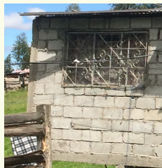
FOTOGRAFÍA N°2.45 Pared de bloque
