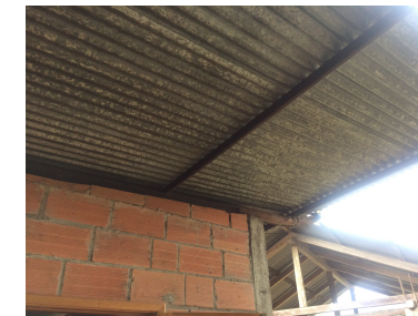
FOTOGRAFÍA N°3.1.6.1.3 Cubierta de zinc
