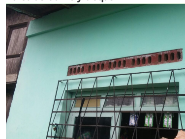
FOTOGRAFÍA N°3.1.11.1.2 Pared de ladrillo y bloque
