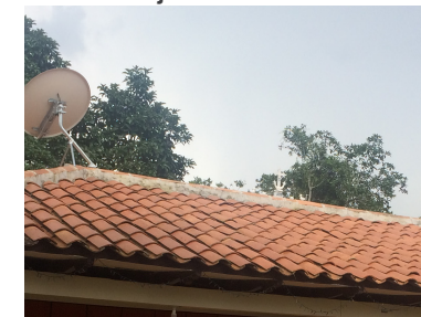
FOTOGRAFÍA N°3.1.8.1.3 Cubierta de teja
