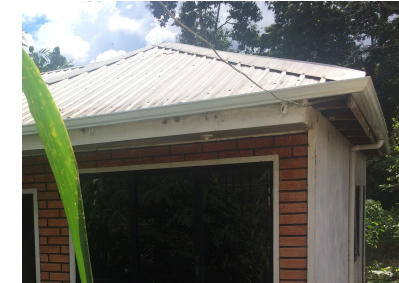
FOTOGRAFÍA N°3.1.4.1.3 Cubierta de galvalum
