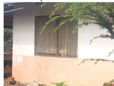
FOTOGRAFÍA N°3.1.5.1.2 Pared de bloque
