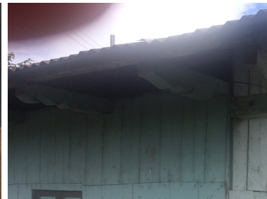
FOTOGRAFÍA N°3.1.10.1.3 Cubierta de zinc
