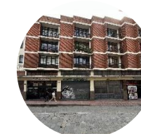
Figura 184. Materialidad propia de la zona
