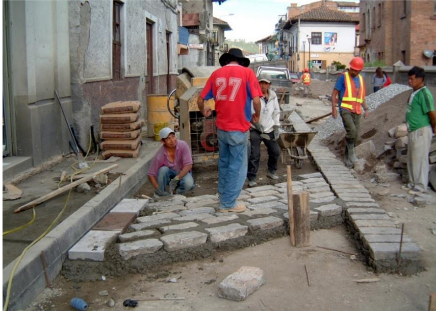
Figura 12. Reforma de la calle Larga Fuente: (Fundación El Barranco, 2014b)
