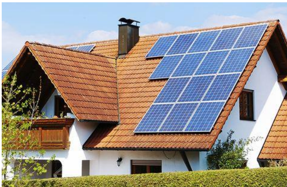
Fig. 2 Casa autosustentable de energía eléctrica mediante la implementación de paneles solares.
