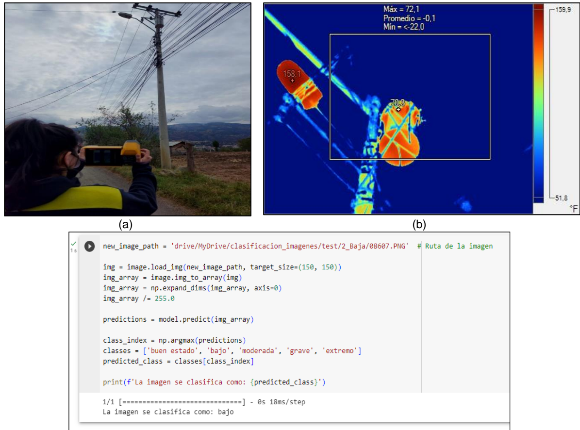
Figura 4.5 a) Recopilación de datos del análisis termográfico en campo, b) termografía en el transformador, c) Resultado obtenido en la predicción de grado de severidad de degradación térmica.
