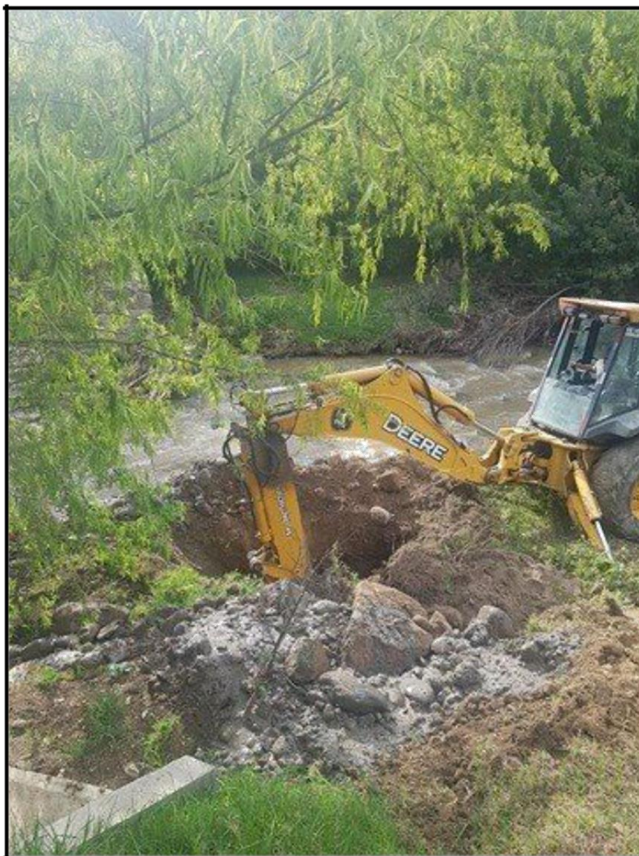
Foto 3: Excavación de Calicata para obtención de muestras de suelo.
