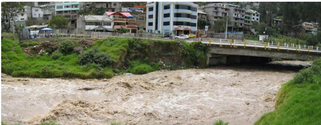
Figura 2.3: Crecida del río Burgay, puente de acceso al mercado Sucre (30-Abril-2009)
