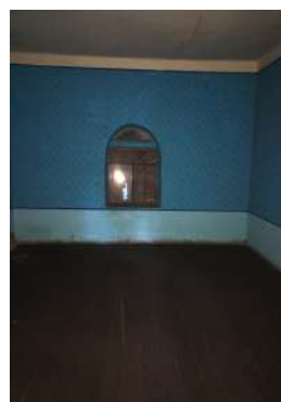
Estructura: Cielo Raso, Pared.
