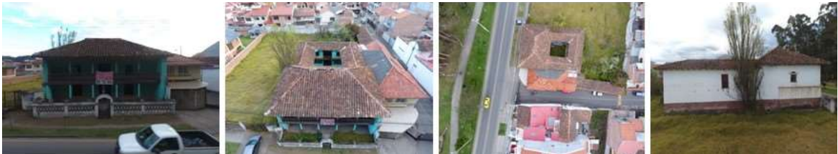
FIGURA 2.22: Vista aérea de la cubierta
