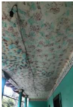
Estructura: Cielo Raso
