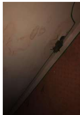
Estructura: Cielo Raso
