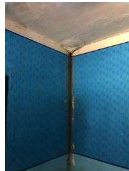
Estructura: Cielo Raso, Pared.
