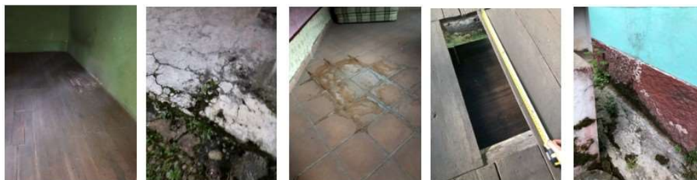
FIGURA 2.16: Algunas lesiones patológicas en pisos
