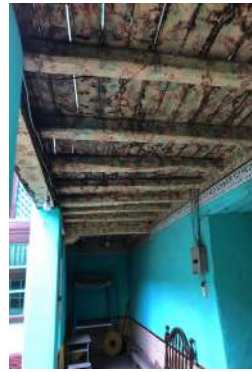
Estructura: Cielo raso
