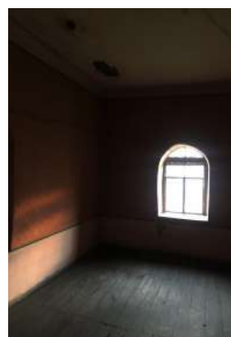
Estructura: Cielo Raso
