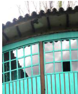
Estructura: Cielo Razo
