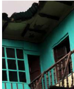
Estructura: Cielo Raso
