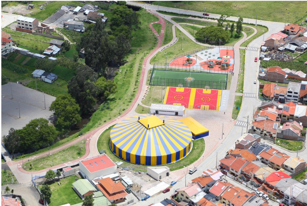
Fotografía N°32: Conjunto del proyecto “Circo Social Cuenca”
