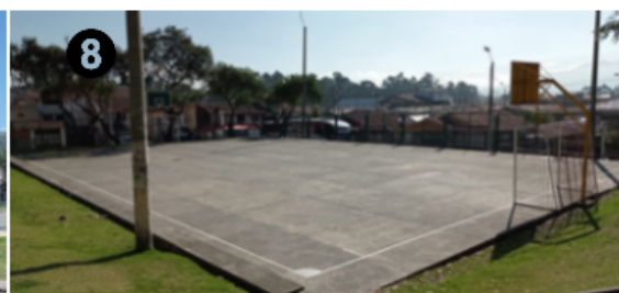
Cancha de Uso Múltiple
